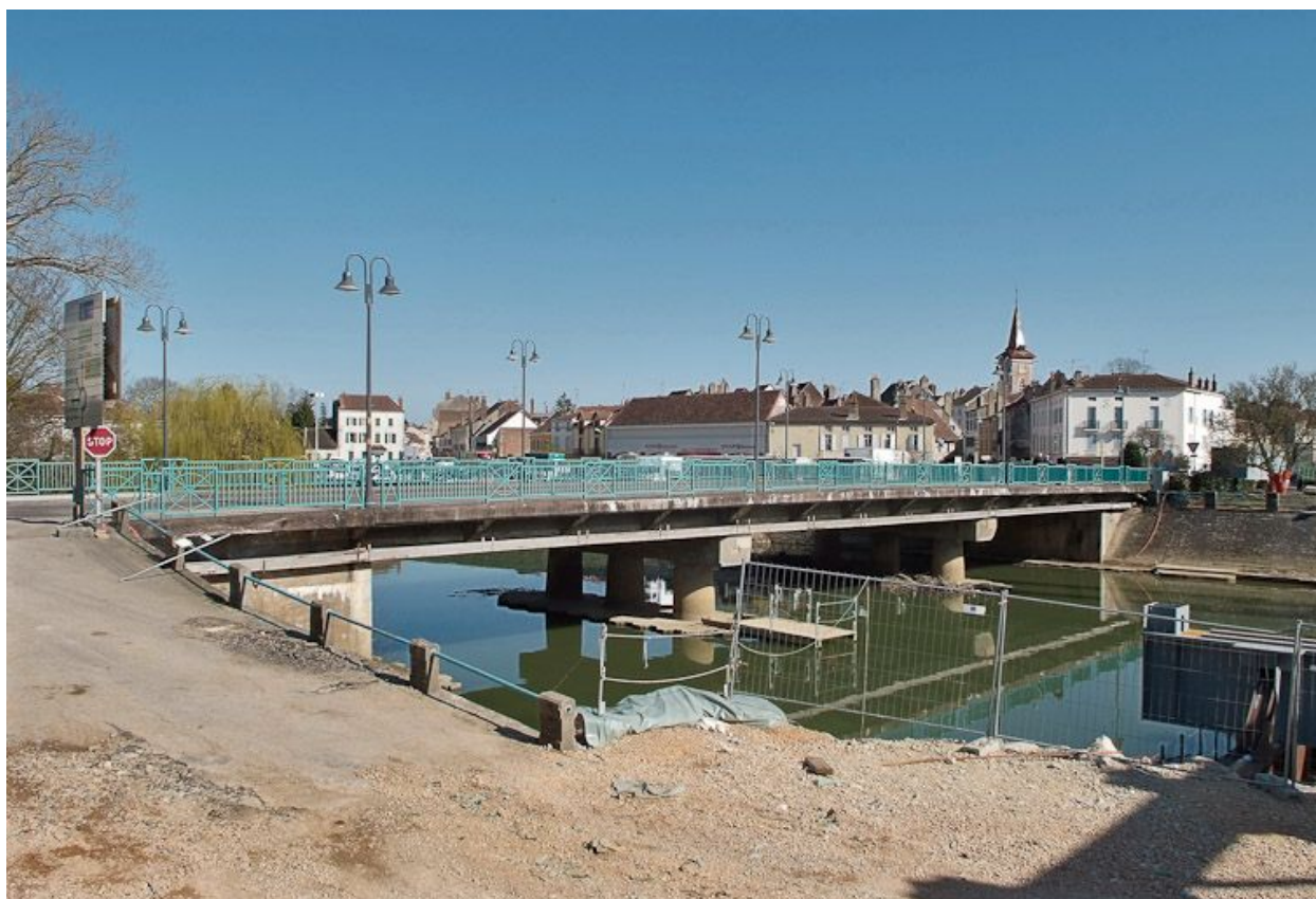
Pont routier sur la Seille, vue d'aval.
