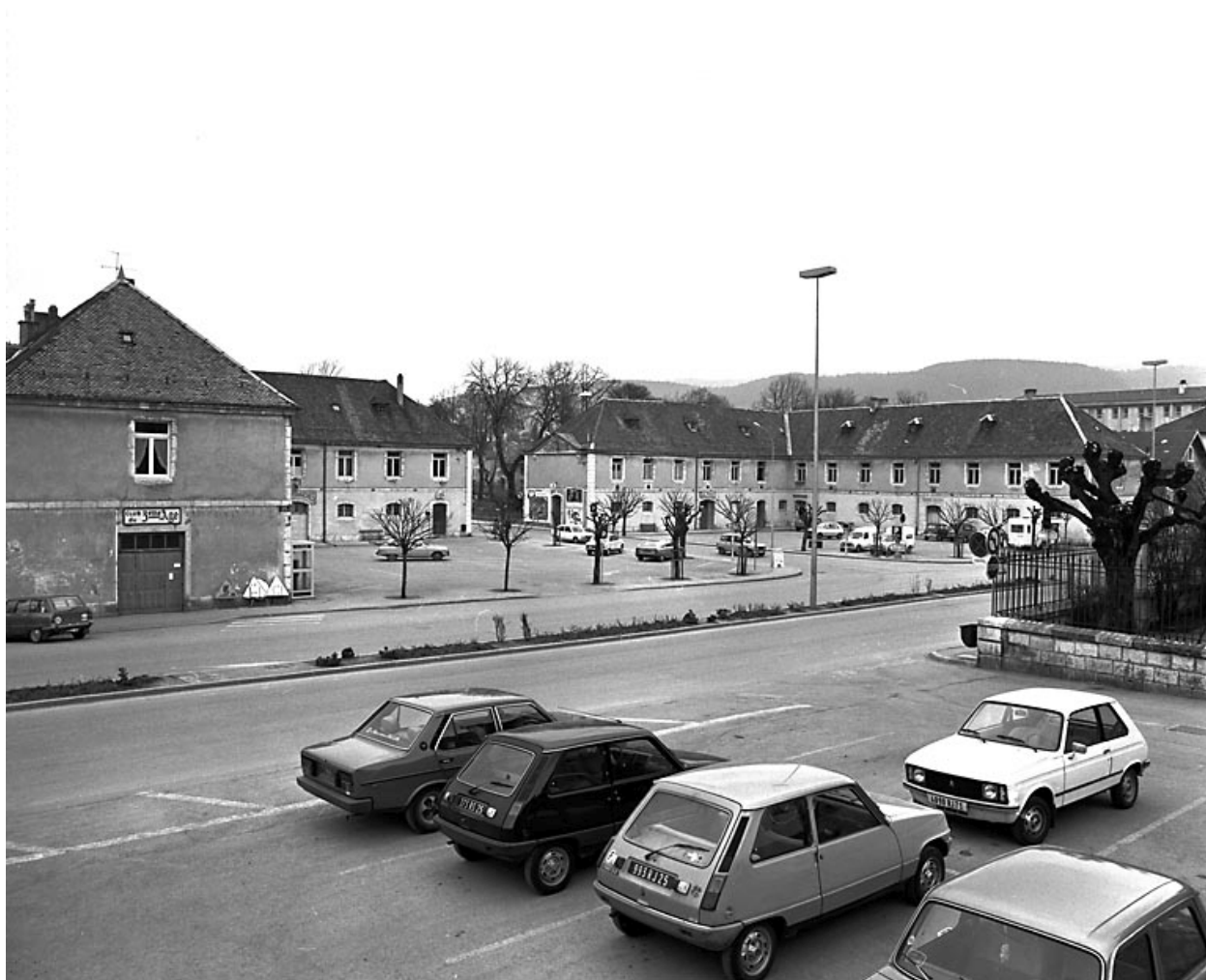
Caserne située place du Général Marguet.
