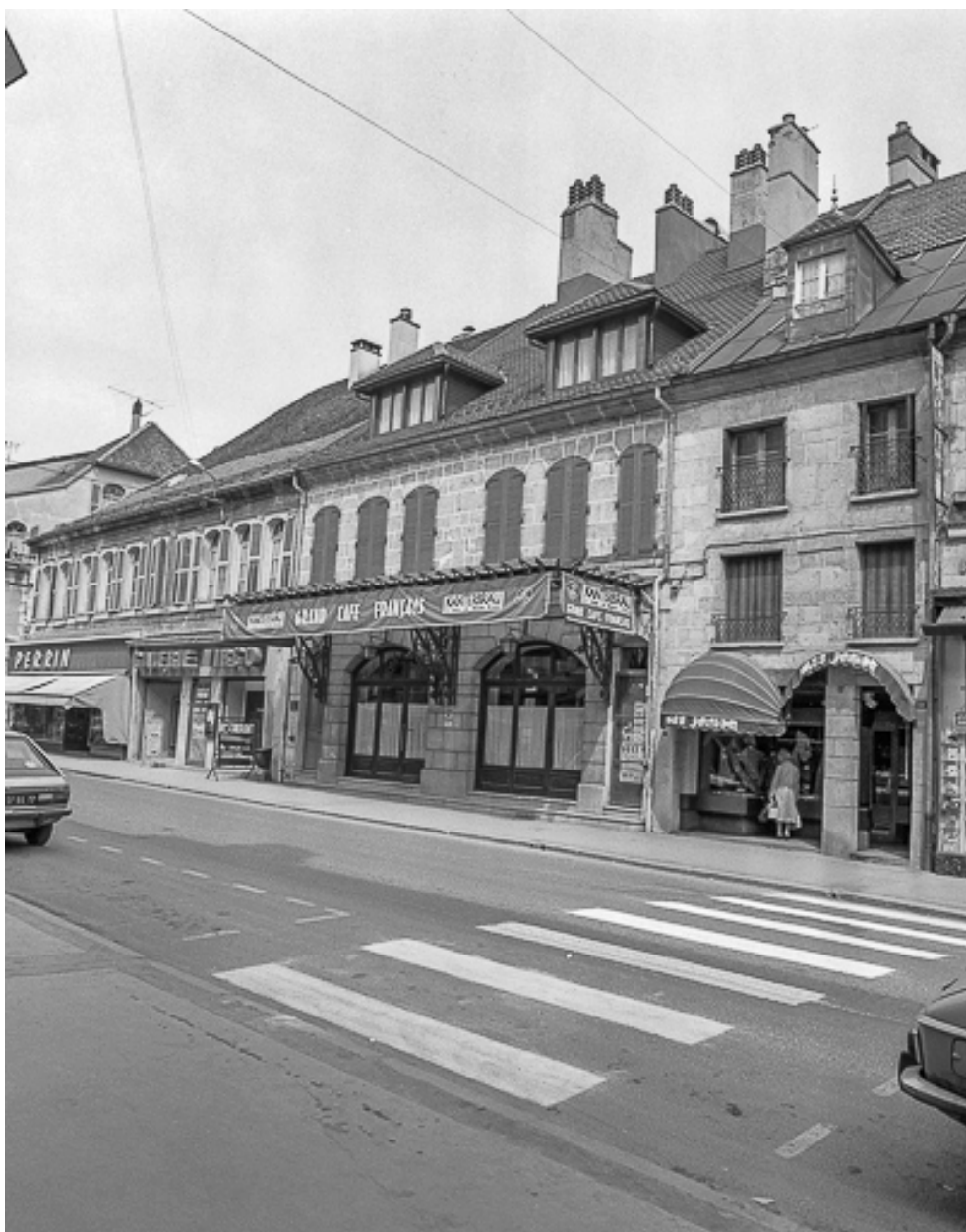
Maisons situées 34 à 38 rue de la République.
