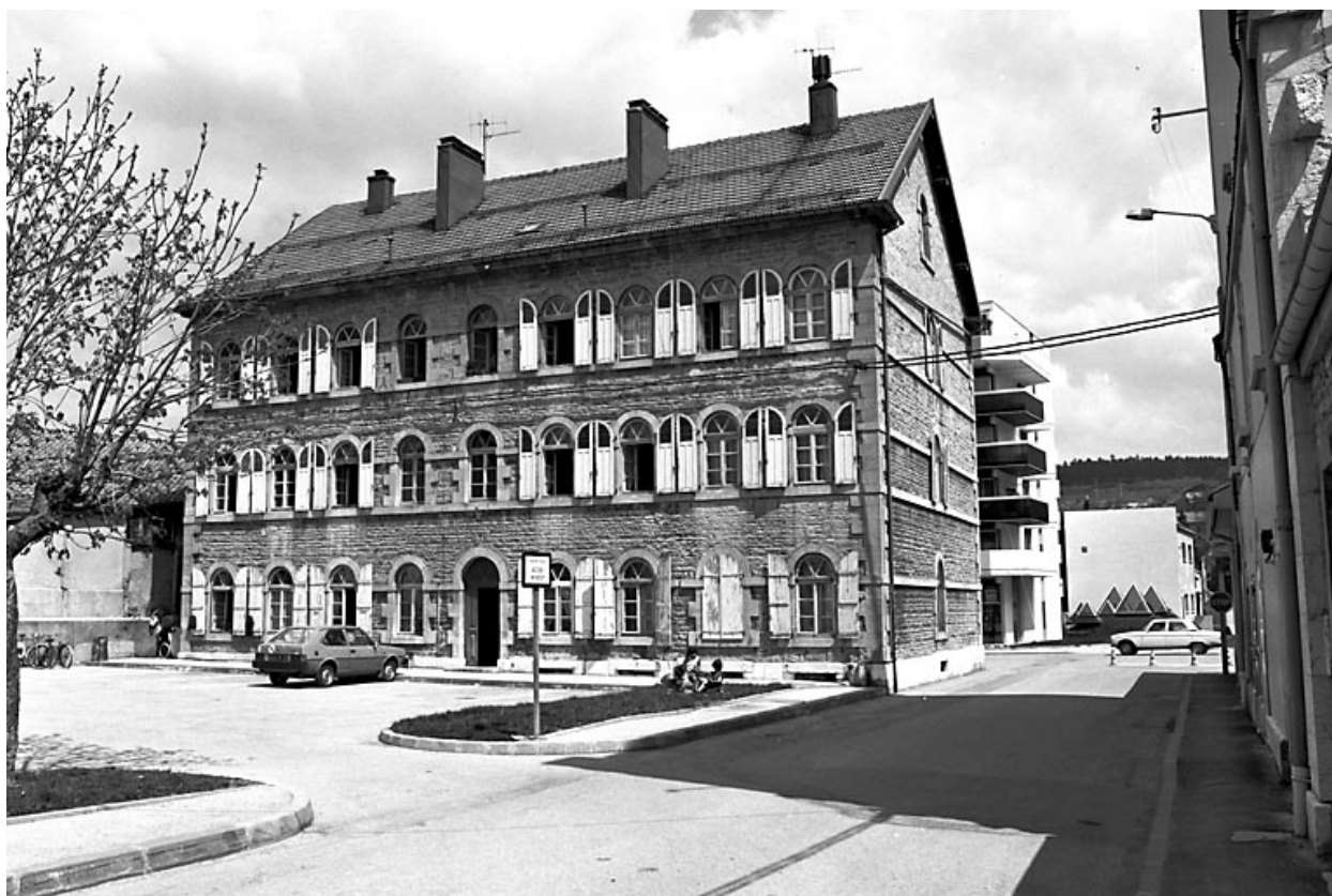
Caserne située place des Bernardines.
