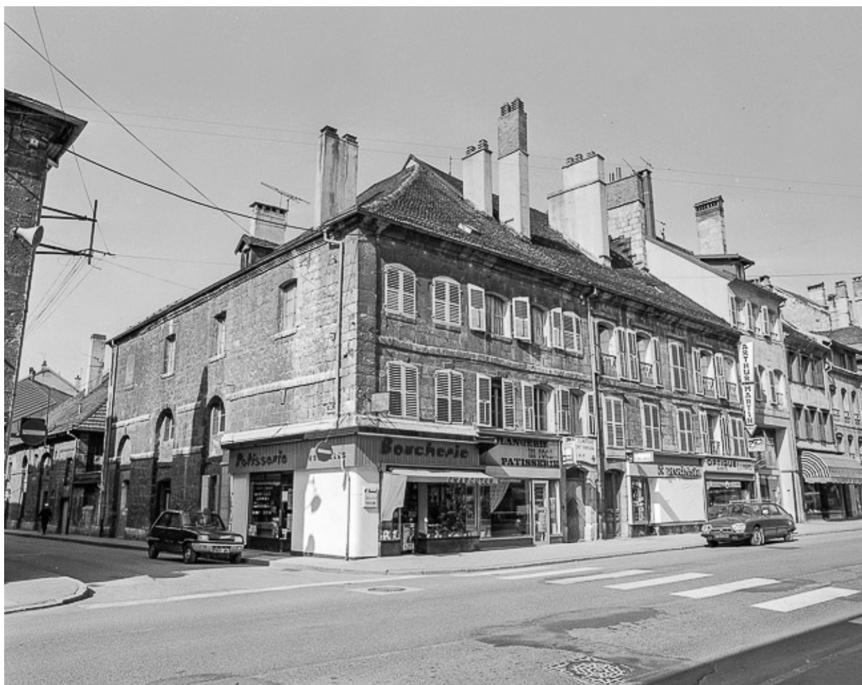
Maisons situées 5 à 11 rue de la République.
