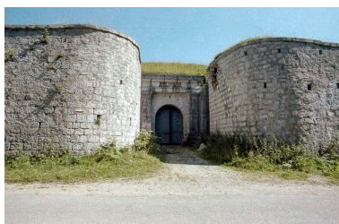
Fort du Larment supérieur dit fort Catinat. Phot. Alain Montferrand IVR43_19802500811ZE
