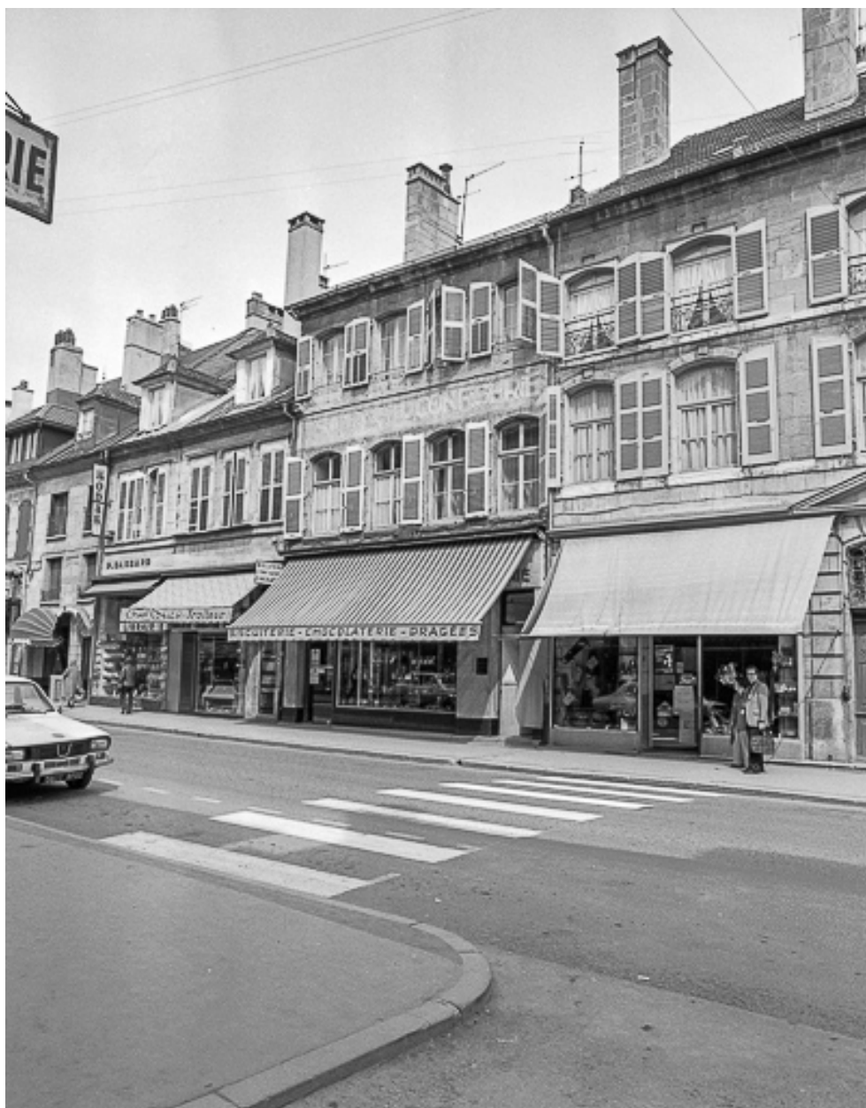
Maisons situées 28 à 34 rue de la République.
