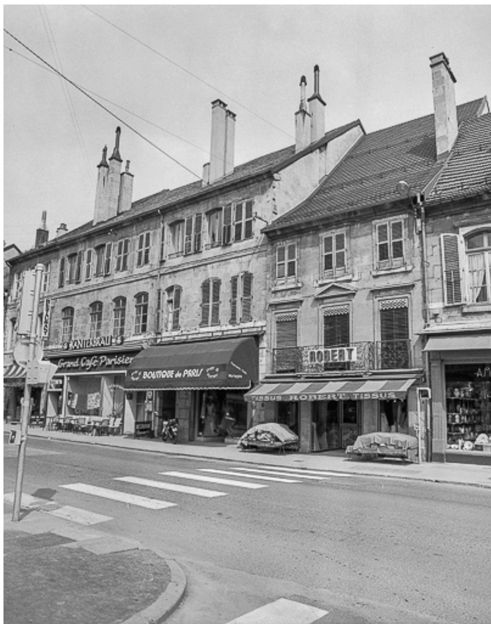
Maisons situées 18 à 22 rue de la République.
