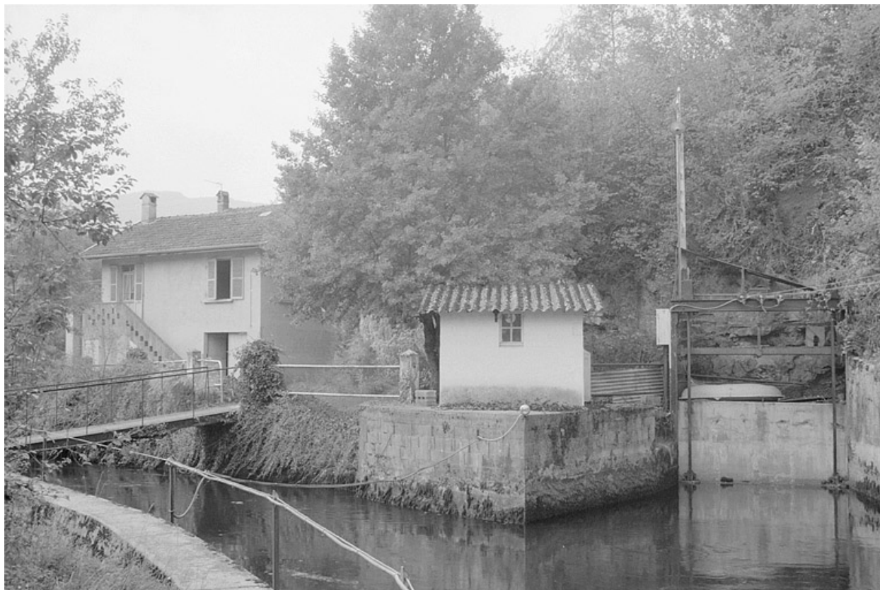
Bifurcation du canal d'amenée.
