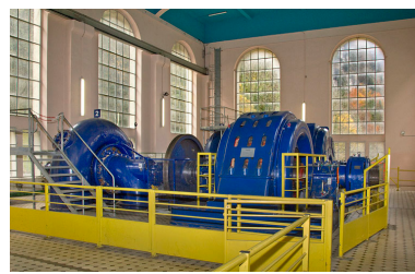
Groupe n° 2 : face avant. Phot. Yves Sancey IVR43_20122502121NUC2A
