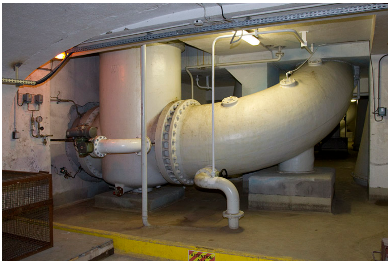
Groupe n° 1 : conduites d'amenée d'eau, à l'étage de soubassement.
