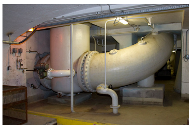
Groupe n° 1 : conduites d'amenée d'eau, à l'étage de soubassement. Phot. Yves Sancey IVR43_20122502146NUC2A
