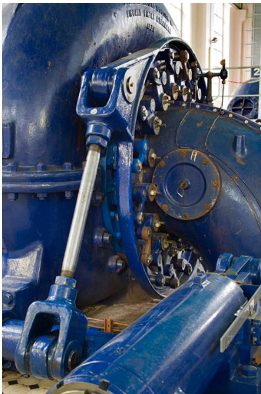
Groupe n° 1 : bras et cercle de vannage de la turbine, permettant d'en régler le débit.
