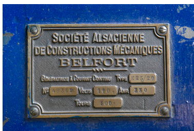
Groupe n° 2 : plaque signalétique de l'alternateur. Phot. Yves Sancey IVR43_20122502136NUC2A
