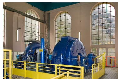
Groupe n° 3 : face avant. Phot. Yves Sancey IVR43_20122502122NUC2A
