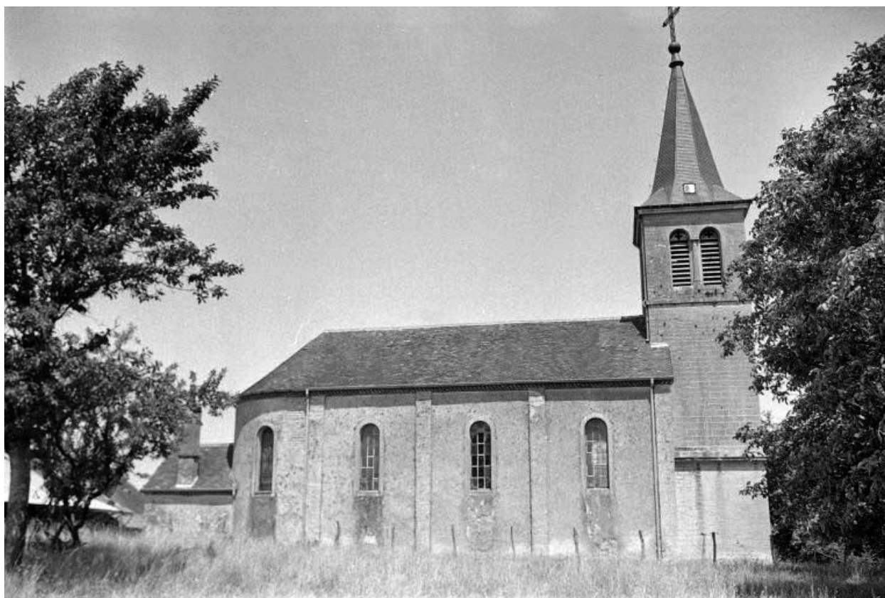
Façade latérale gauche : vue rapprochée.
