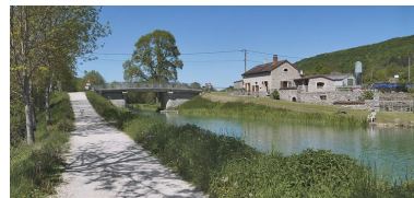
Maison de garde prise d'amont.
