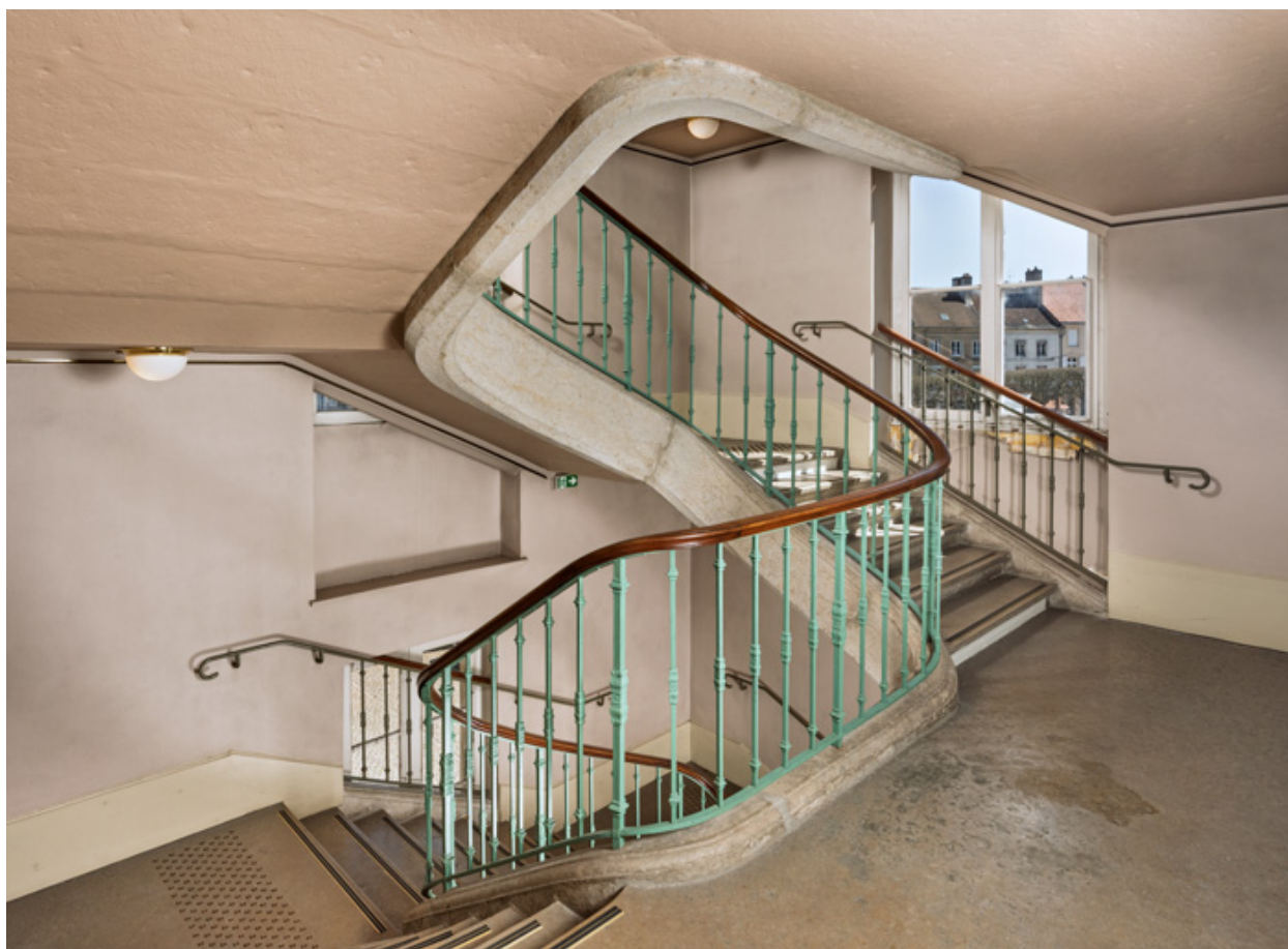
Escalier côté cour : un palier.
