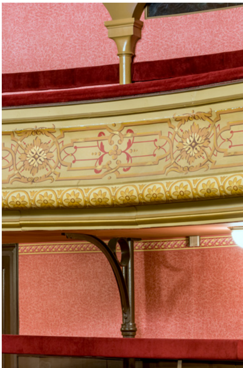
Garde-corps du 3e balcon et poteaux métalliques.
