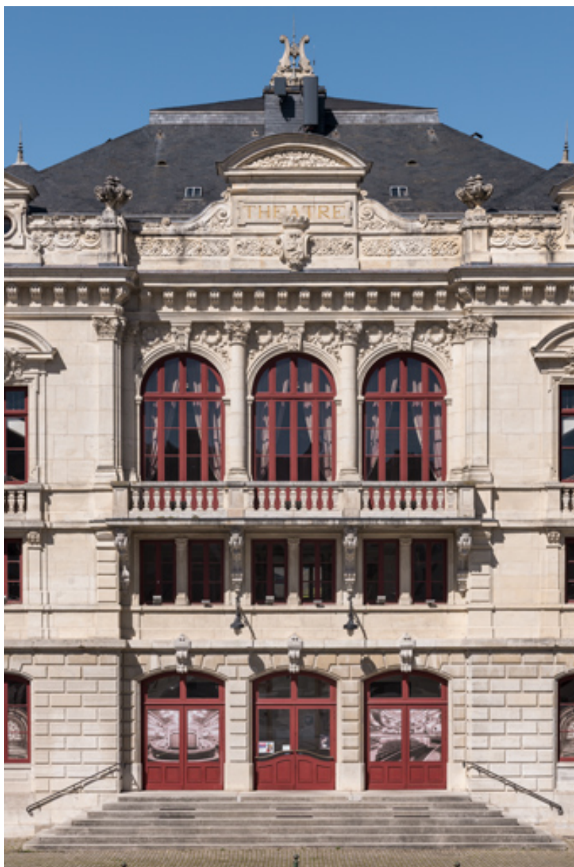
Façade antérieure : travée centrale.
