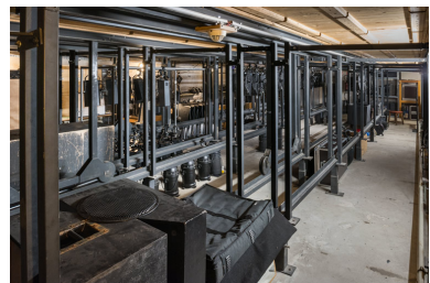
Dessous de scène. Phot. Pierre-Marie Barbe-Richaud IVR26_20257100225NUC4A
