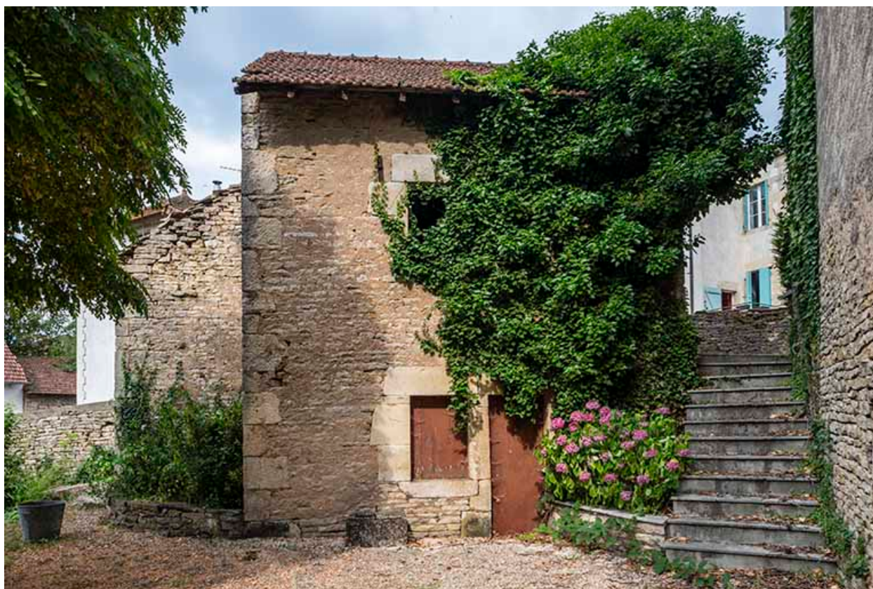
Remise du presbytère.
