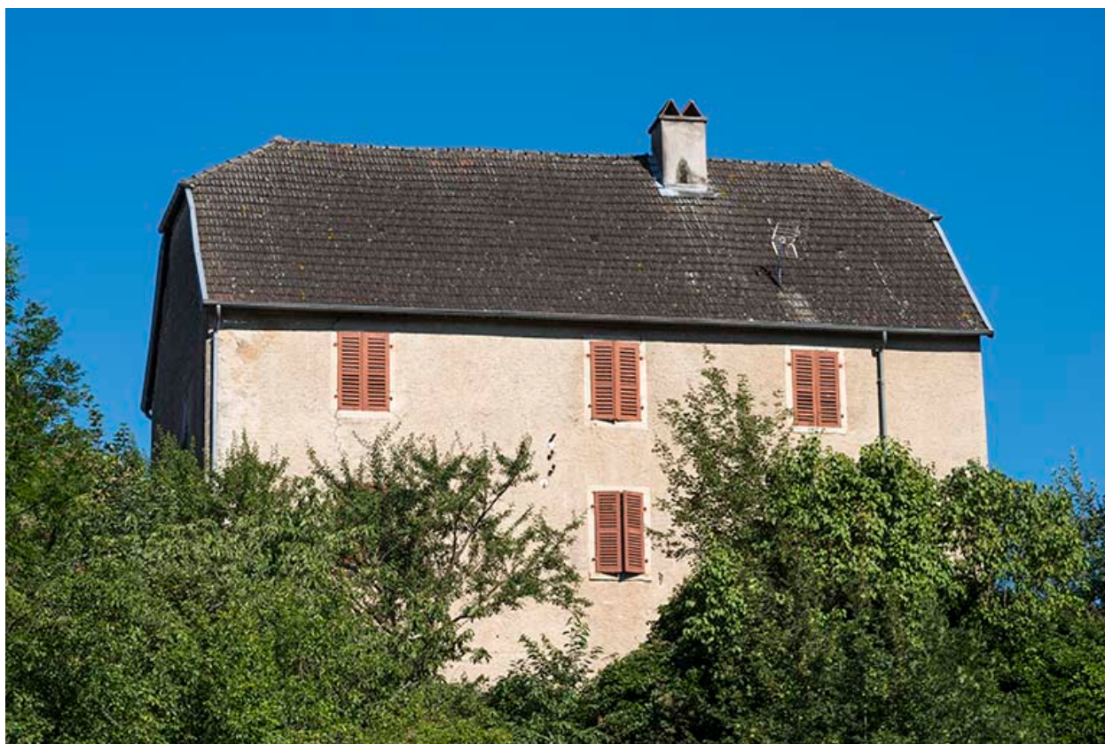
Étages supérieurs de la façade postérieure.
