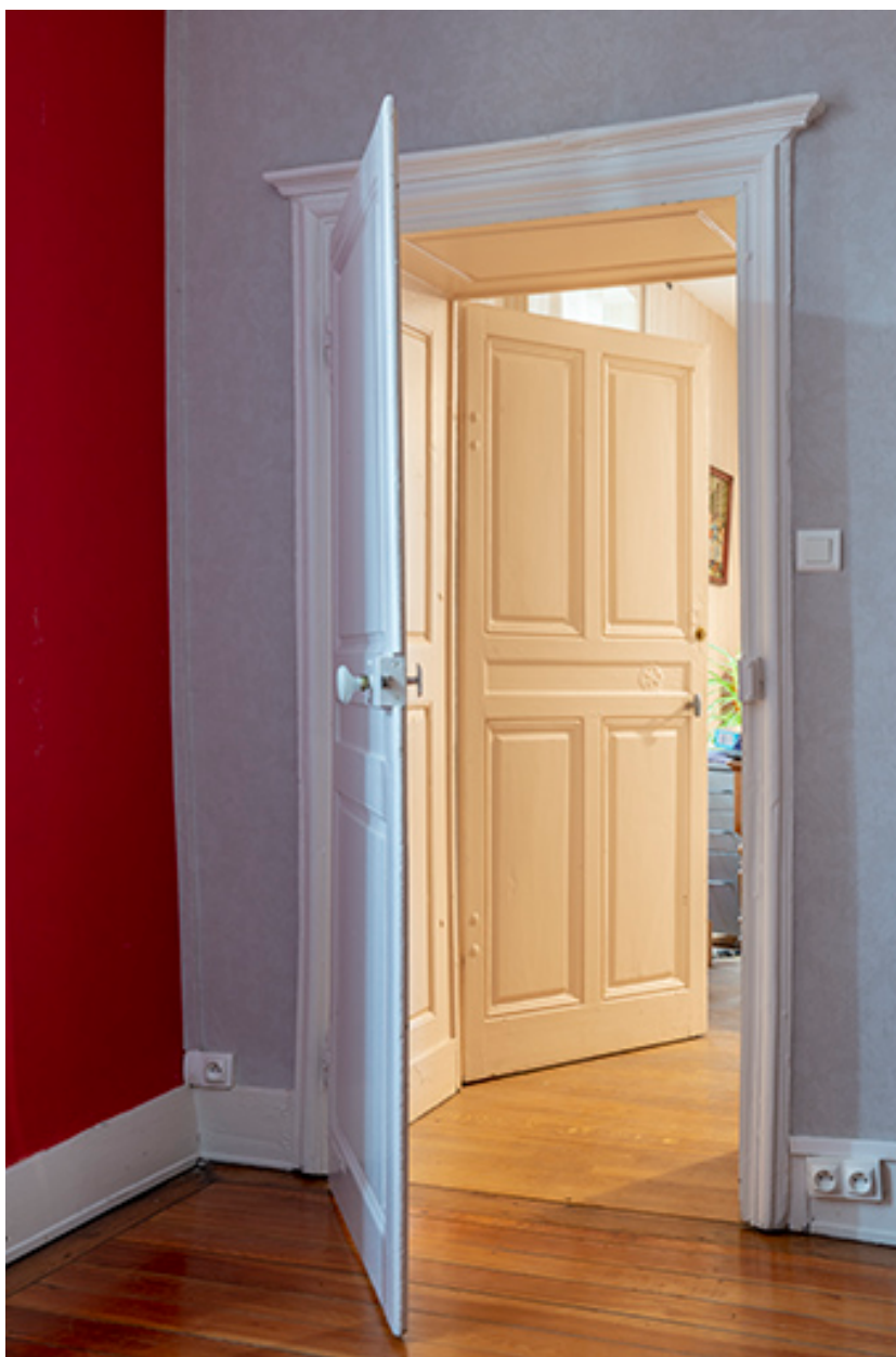
Portes d'enfilade, rez-de-chaussée du presbytère.
