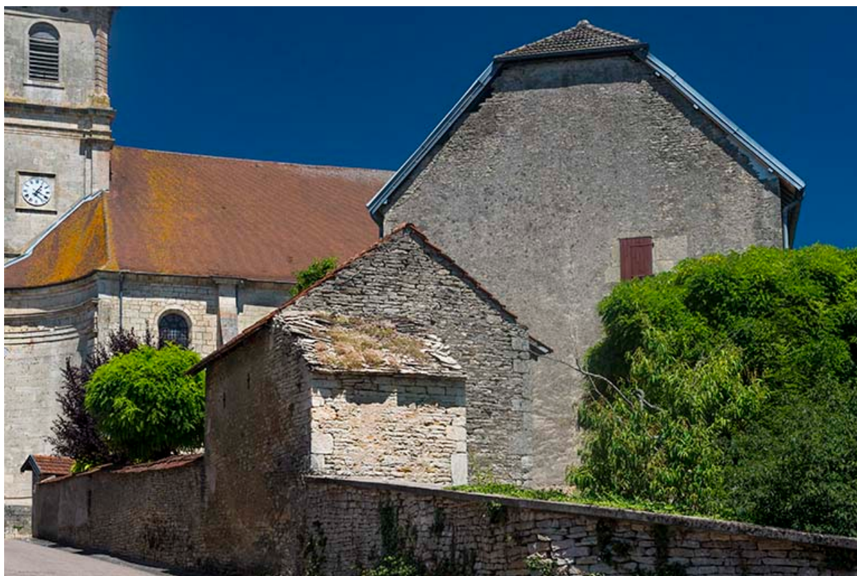
Mur pignon sud.
