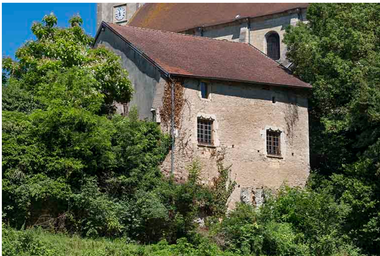
Façade postérieure de l'ancienne cure.
