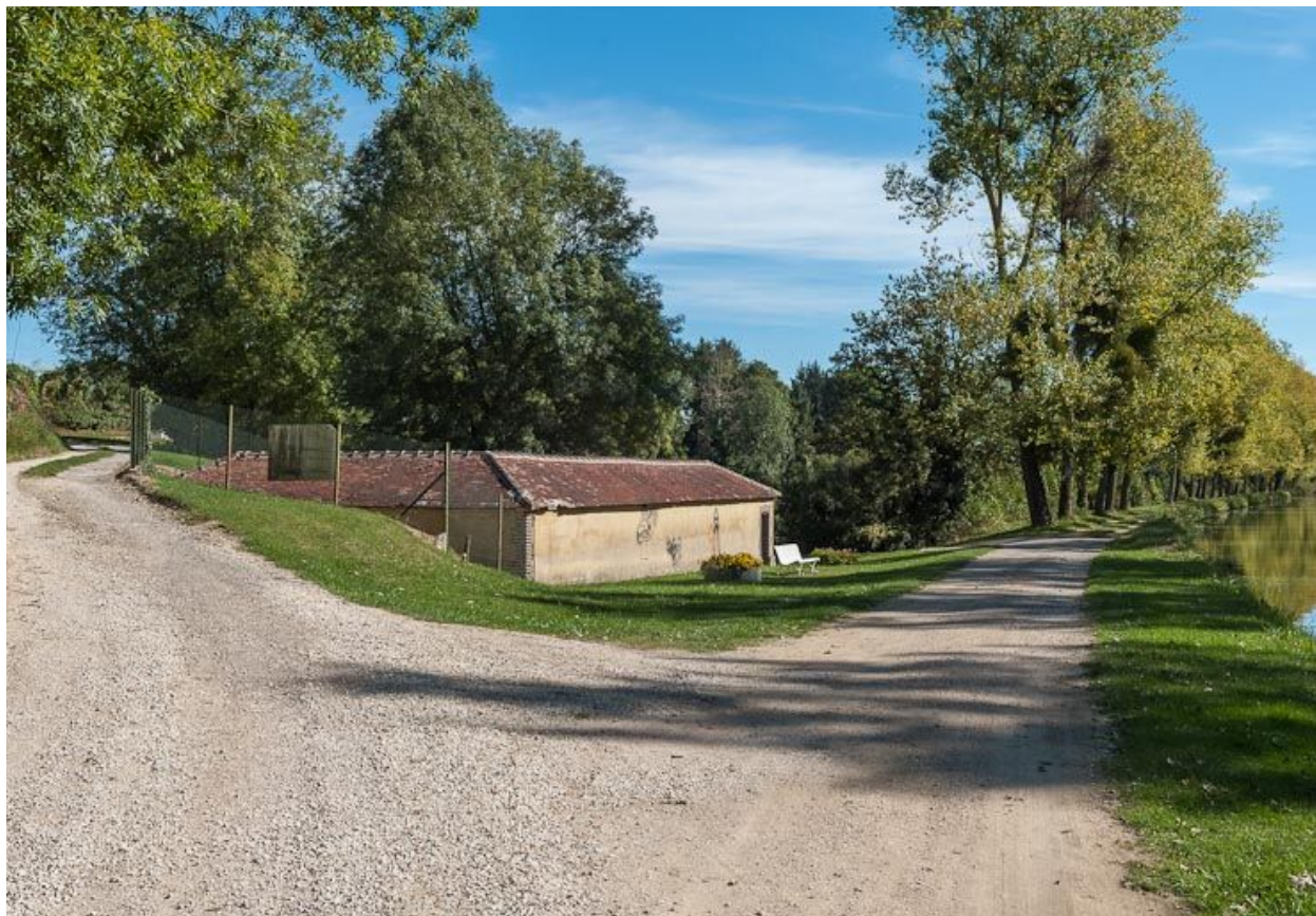
Vue d'ensemble du lavoir.
