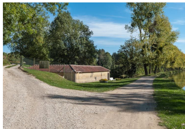
Vue d'ensemble du lavoir.
