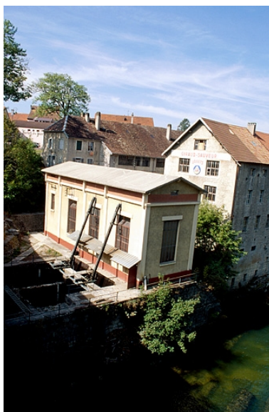
La centrale hydroélectrique. Phot. Yves Sancey IVR43_19973901319ZA
