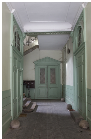
Intérieur : vue du passage cocher.
