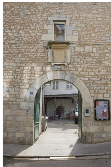
Façade latérale droite : détail du portail d'entrée.
