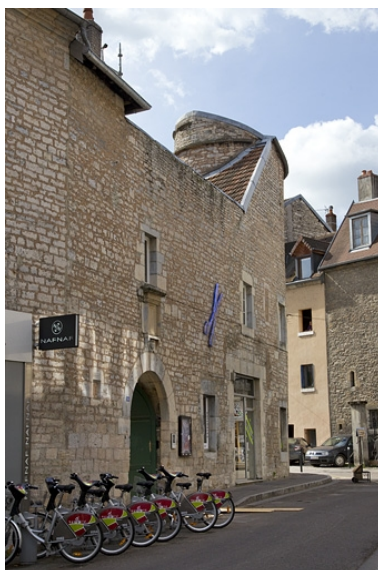
Façade latérale droite : de trois quarts gauche.
