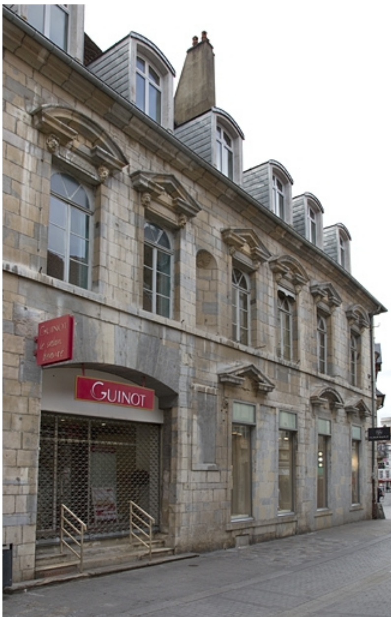
Façade antérieure : détail de la partie droite.
