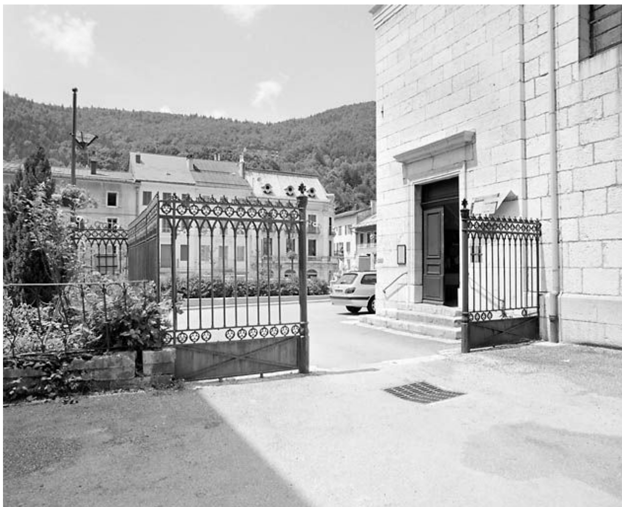
Grille à l'entrée de la cour.
