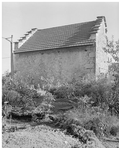
L'ancienne fromagerie de Ponthoux, face sud. Phot. Jérôme Mongreville IVR43_19963901058X
