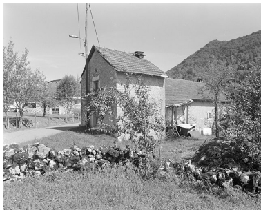
Ferme sur la commune de Ponthoux. Phot. Jérôme Mongreville IVR43_19963901034X
