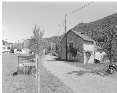
Rue principale du village. Phot. Jérôme Mongreville IVR43_19963901035X
