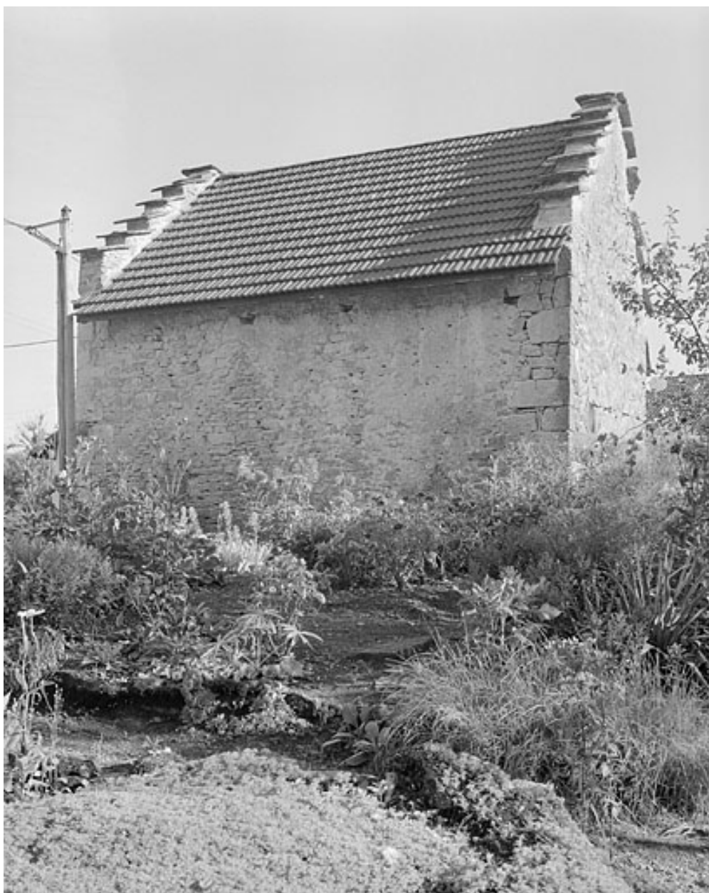
L'ancienne fromagerie de Ponthoux, face sud.
