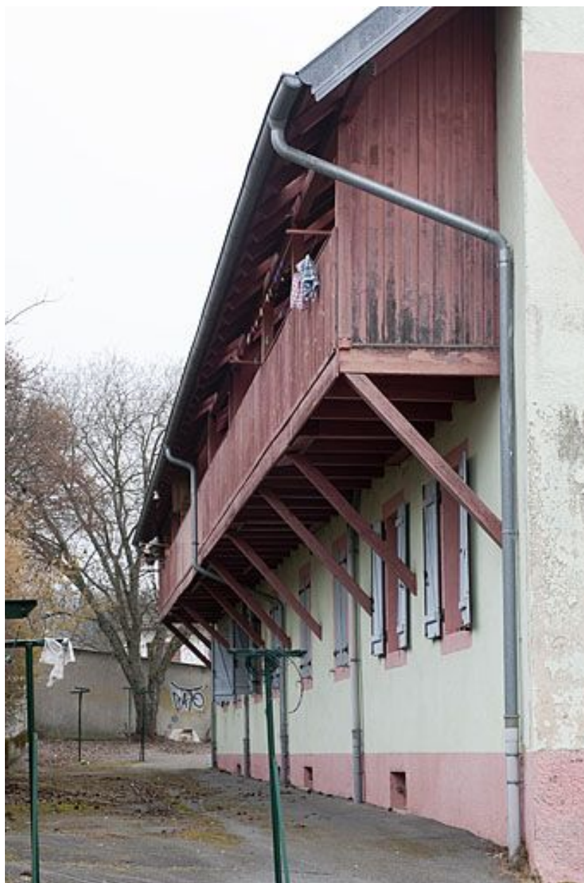
Façade postérieure de l'immeuble de 10 logements.
