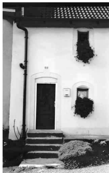
Façade antérieure : détail. Phot. Bernard Lardière IVR43_19832500098Z
