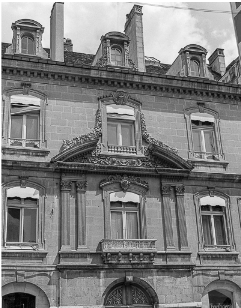
Détail du corps central.
