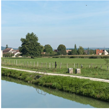
Vue de l'arrivée de la rigole. Phot. Pierre-Marie Barbe-Richaud IVR26_20112104027NUC2AQ
