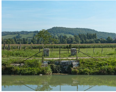
Vue de face de l'arrivée de la rigole. Phot. Pierre-Marie Barbe-Richaud IVR26_20112104028NUC4AQ
