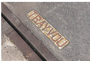
Pont-bascule : détail de la signature de l'entreprise Trayvou. Phot. Thierry Kuntz IVR26_20267100495NUC4A
