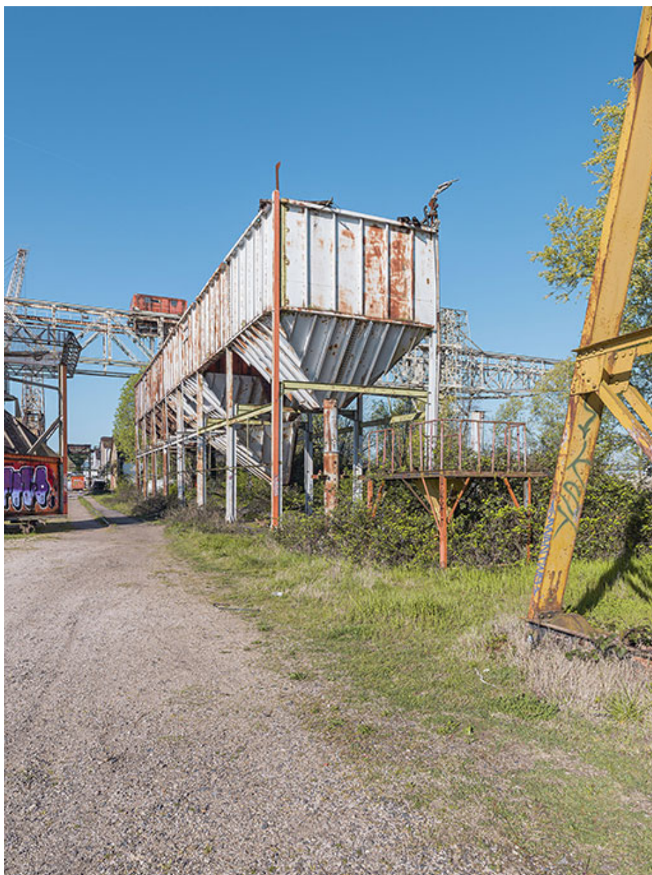
Trémies le long du quai.
