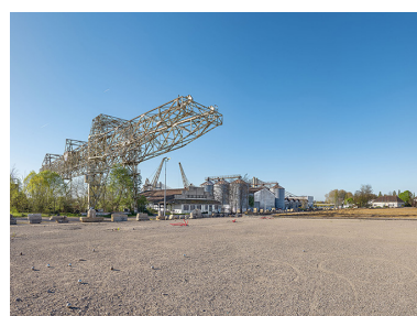
Pont-portique "Jeumont". Phot. Thierry Kuntz IVR26_20267100499NUC4A
