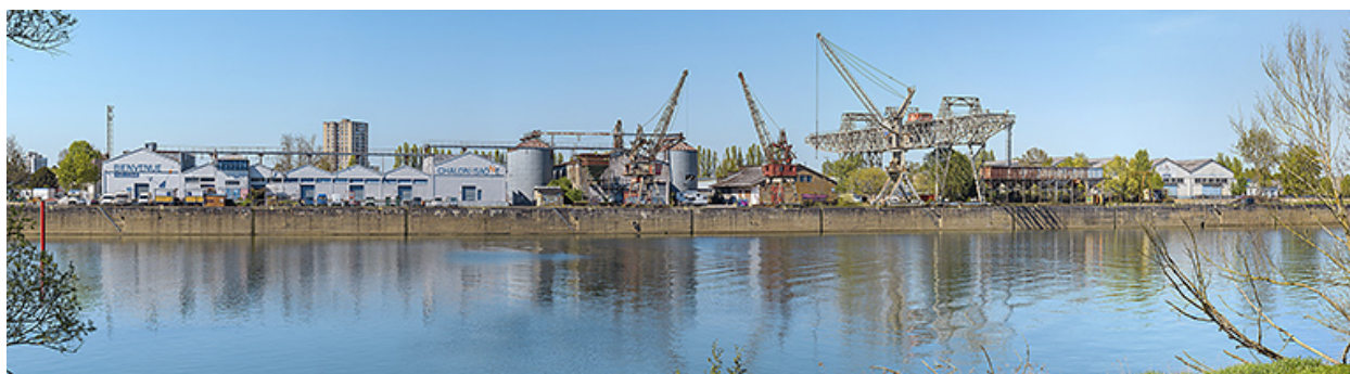
Infrastructures et outillage du port nord, depuis la rive gauche de la Saône.
