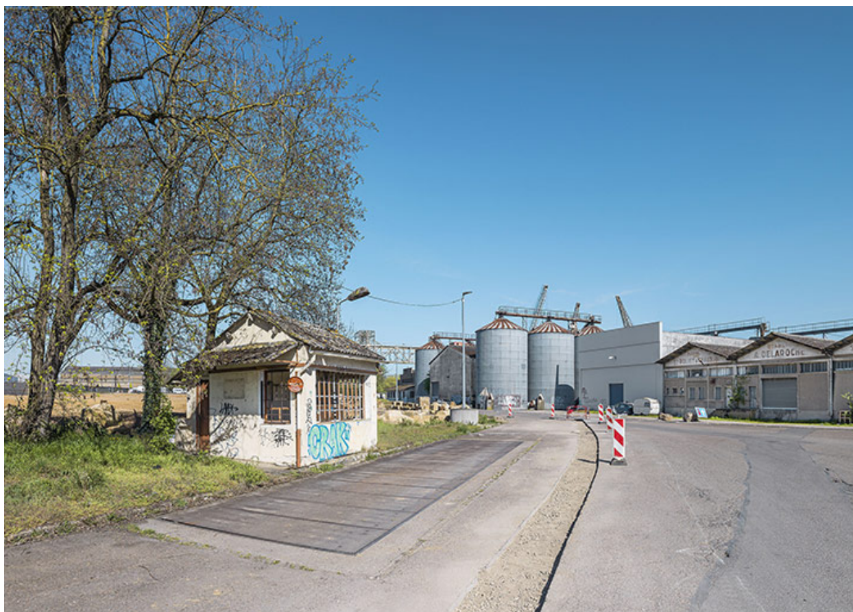
Pont-basculer (routier) et son poste de commande (désaffecté).
