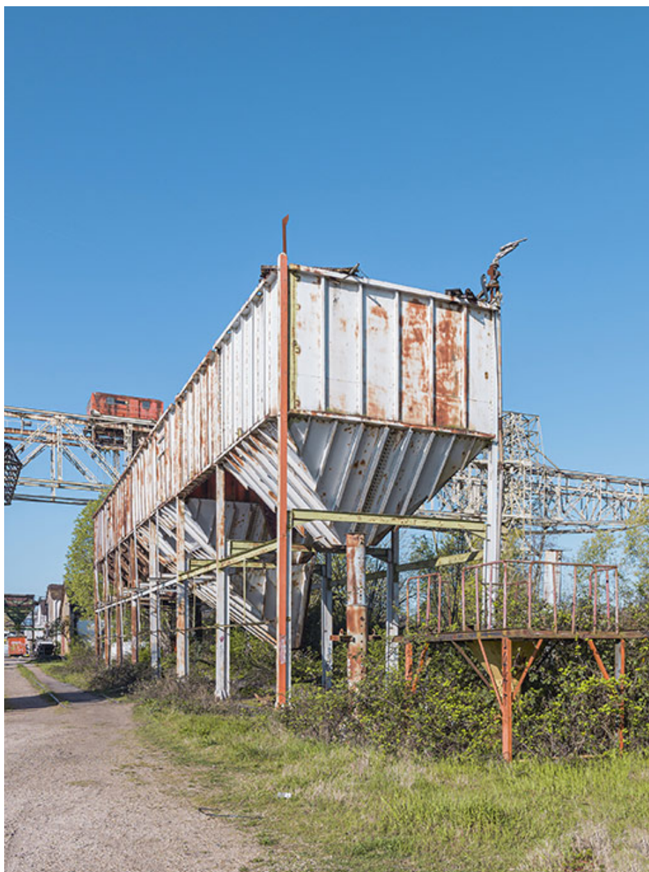
Trémies le long du quai.
