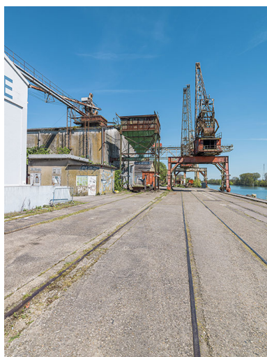
Trémie, grues et rails, le long du quai. Phot. Thierry Kuntz IVR26_20267100491NUC4A
