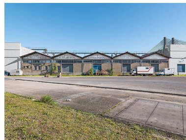
Magasin-entrepôt désaffecté (anciennement Magasins Généraux) : façade côté rue. Phot. Thierry Kuntz IVR26_20267100502NUC4A
