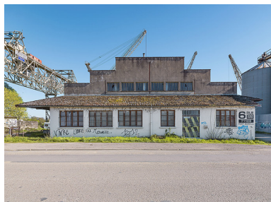
Magasin-entrepôt désaffecté (anciennement Etablissements Delaroche) : façade côté rue. Phot. Thierry Kuntz IVR26_20267100500NUC4A
