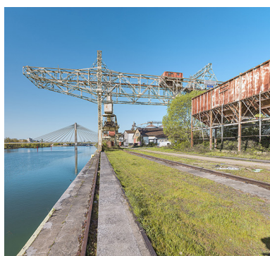
Pont-portique et trémies, le long du quai.
