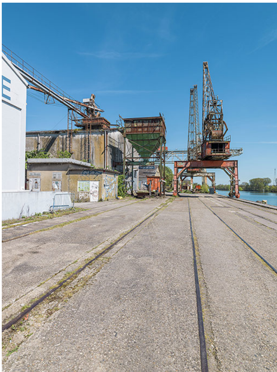
Trémie, grues et rails, le long du quai.
