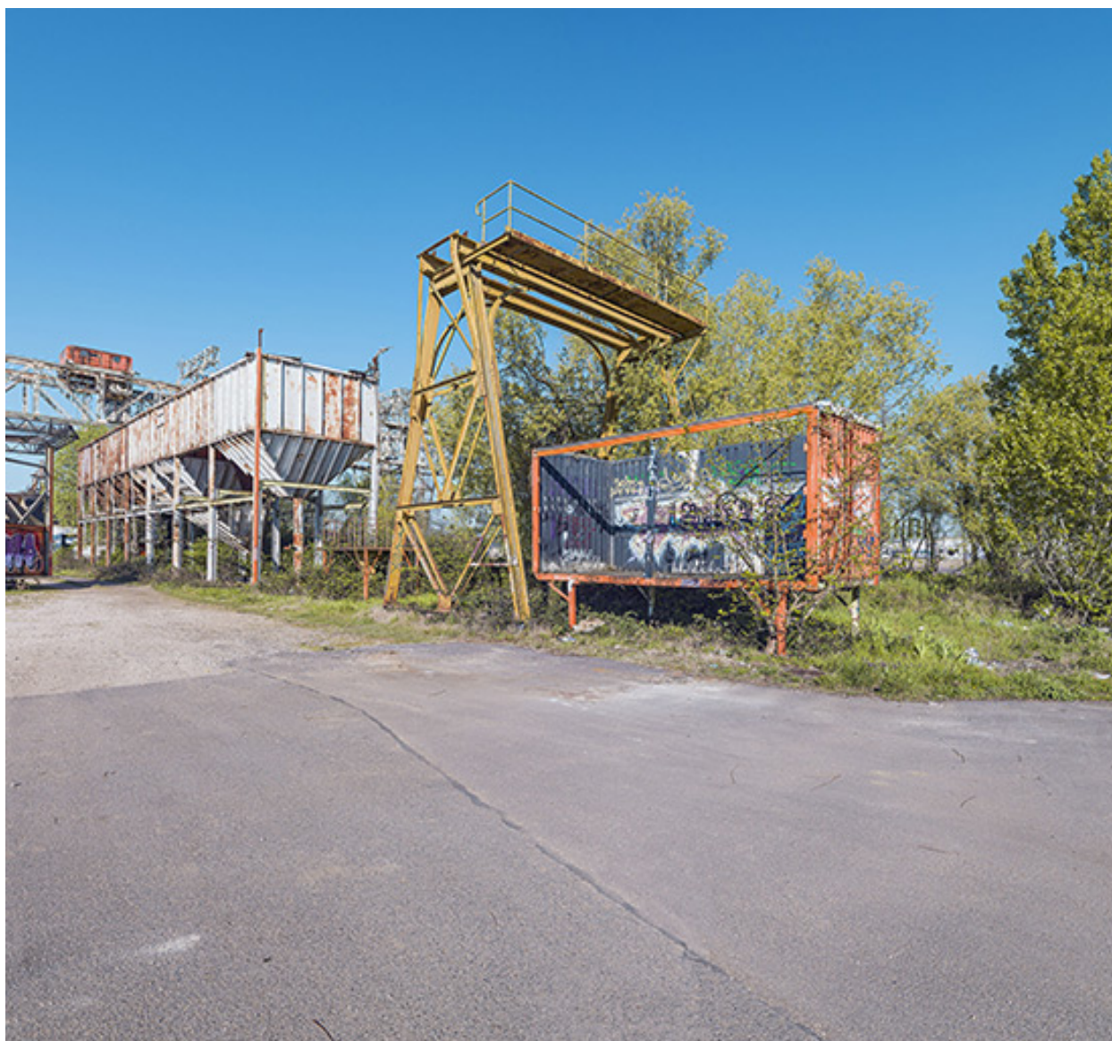
Trémies le long du quai.
