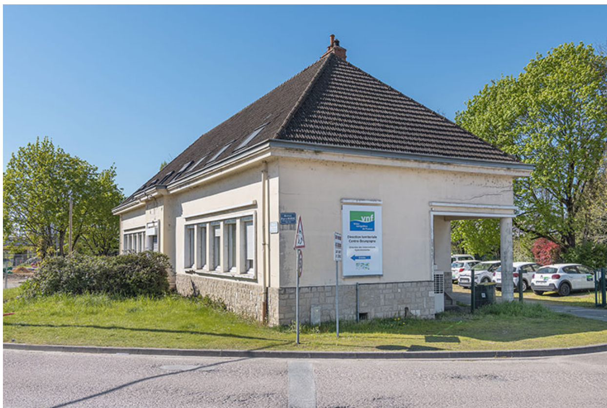
Bureau du port (VNF) : vue de trois quarts.
