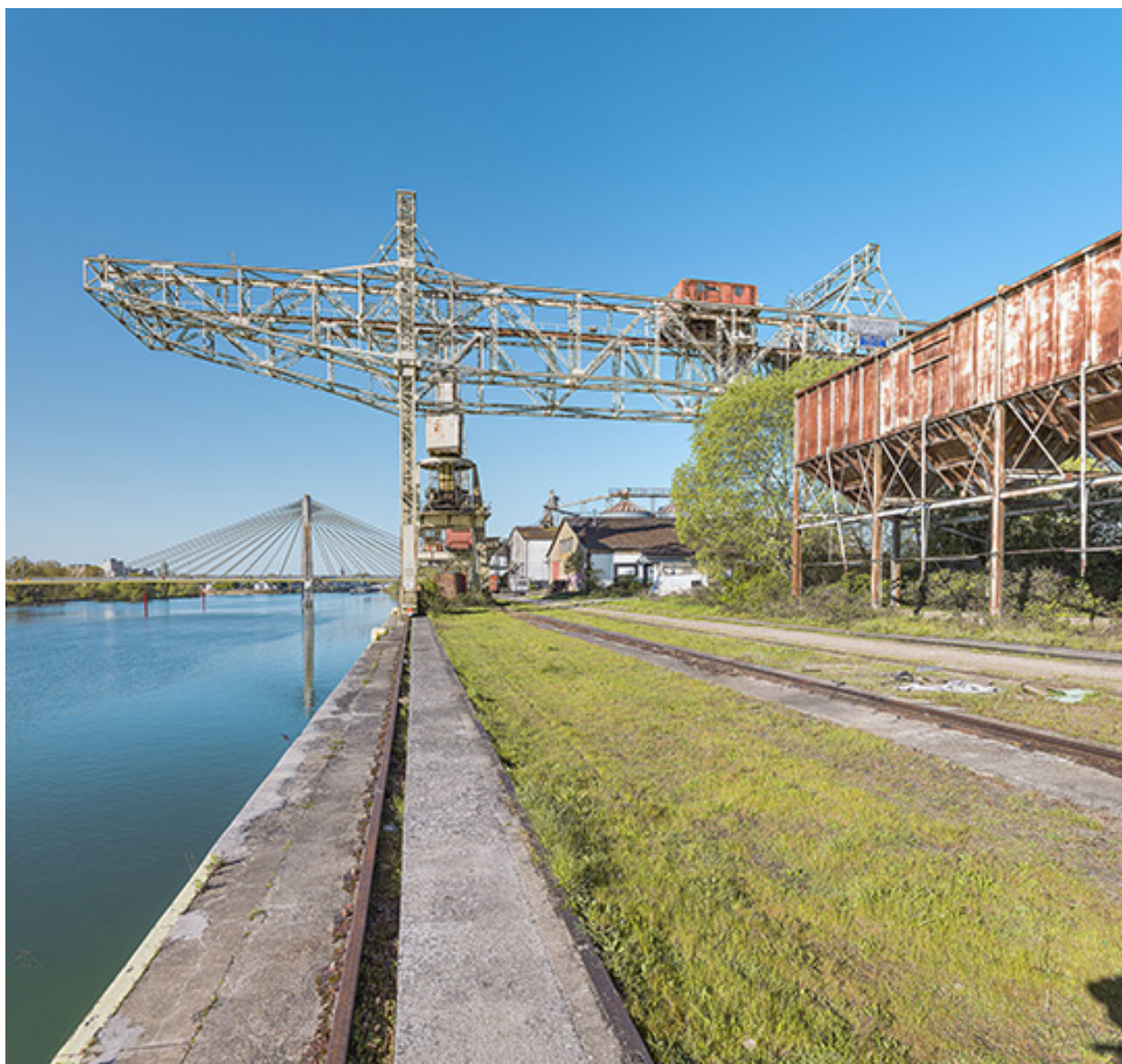
Pont-portique et trémies, le long du quai.
