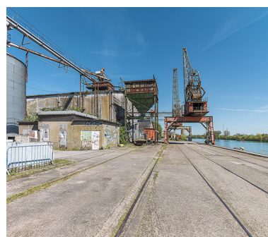
Trémie, grues et rails le long du quai.
