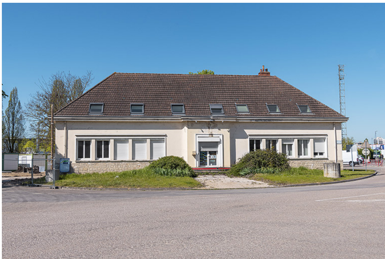
Bureau du port (VNF) : façade principale.
