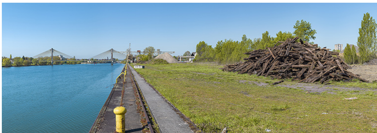
Le mur de quai.
