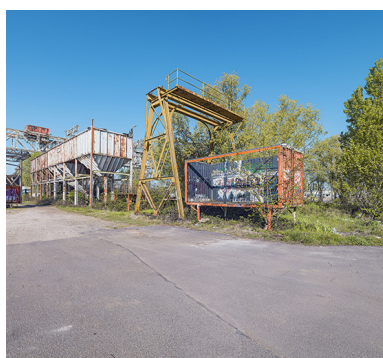
Trémies le long du quai.
