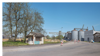
Pont-bascule (routier) et son poste de commande (désaffecté). Phot. Thierry Kuntz IVR26_20267100505NUC4A
