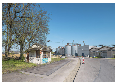
Pont-bascule (routier) et son poste de commande (désaffecté). Phot. Thierry Kuntz IVR26_20267100506NUC4A
