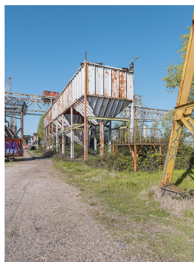
Trémies le long du quai.
