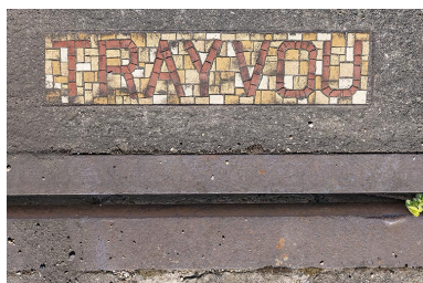
Pont-bascule : détail de la signature de l'entreprise Trayvou. Phot. Thierry Kuntz IVR26_20267100494NUC4A
