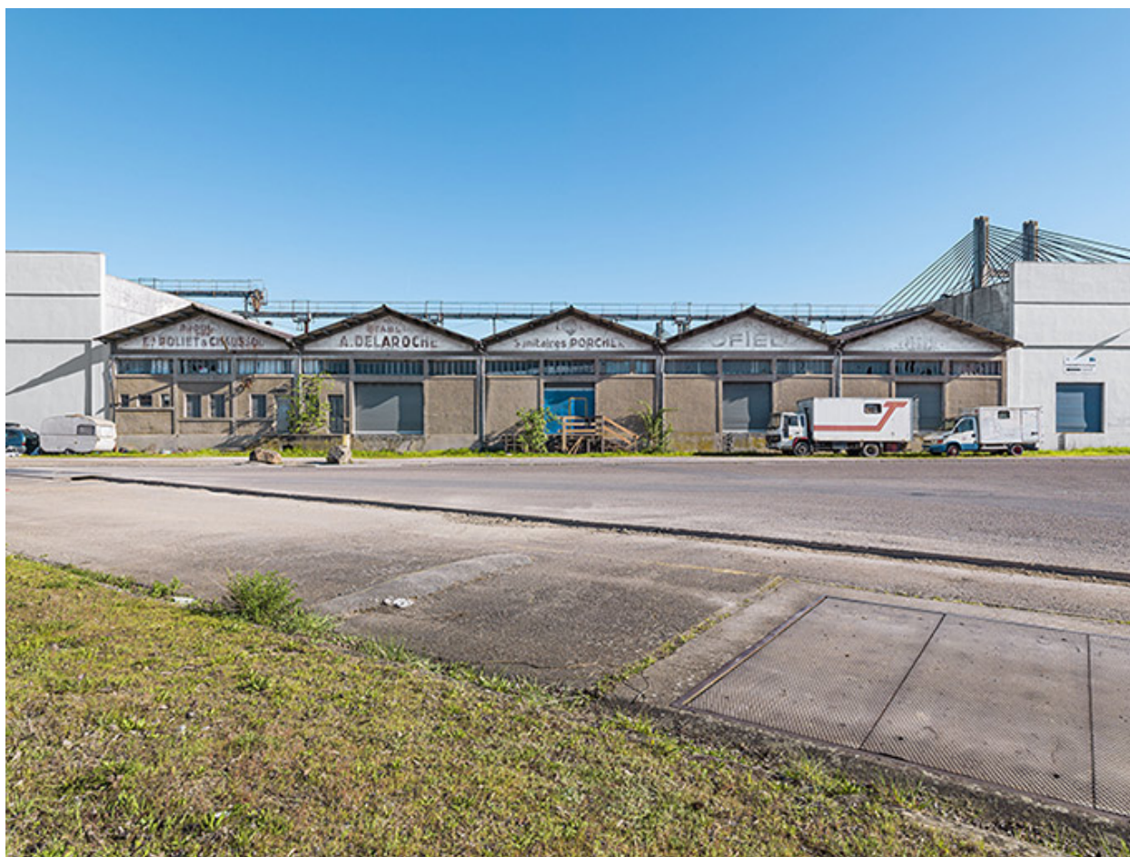
Magasin-entrepôt désaffecté (anciennement Magasins Généraux) : façade côté rue.
