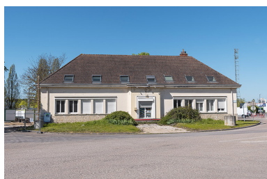
Bureau du port (VNF) : façade principale. Phot. Thierry Kuntz IVR26_20267100503NUC4A
