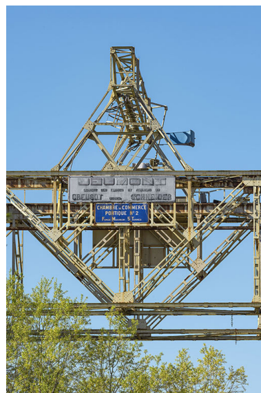
Pont-portique "Jeumont". Phot. Thierry Kuntz IVR26_20267100496NUC4A
