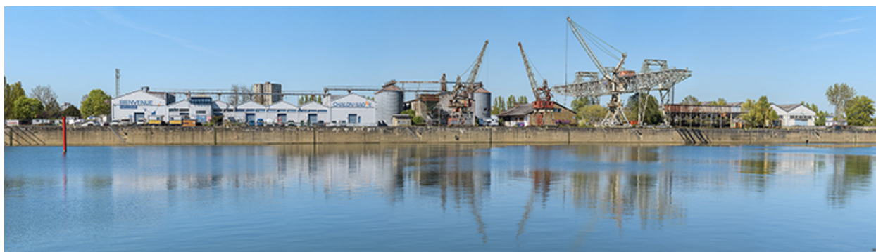
Infrastructures et outillage du port nord, depuis la rive gauche de la Saône.
