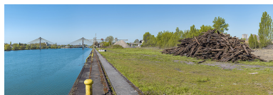
Le mur de quai.
