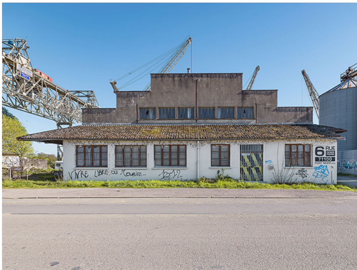
Magasin-entrepôt désaffecté (anciennement Etablissements Delaroche) : façade côté rue.
