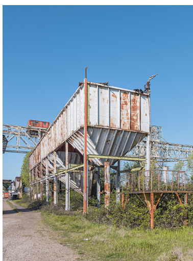
Trémies le long du quai.
