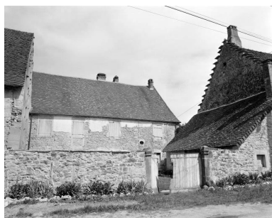
Vue générale. Phot. Bernard Lardière IVR43_19793900336X
