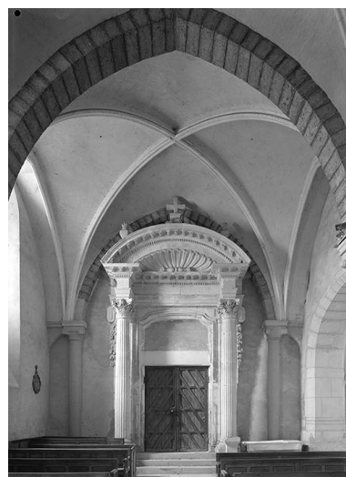
Travée d'un bas-côté avec porte monumentale. Phot. Michel Thierry IVR26_19748900586V
