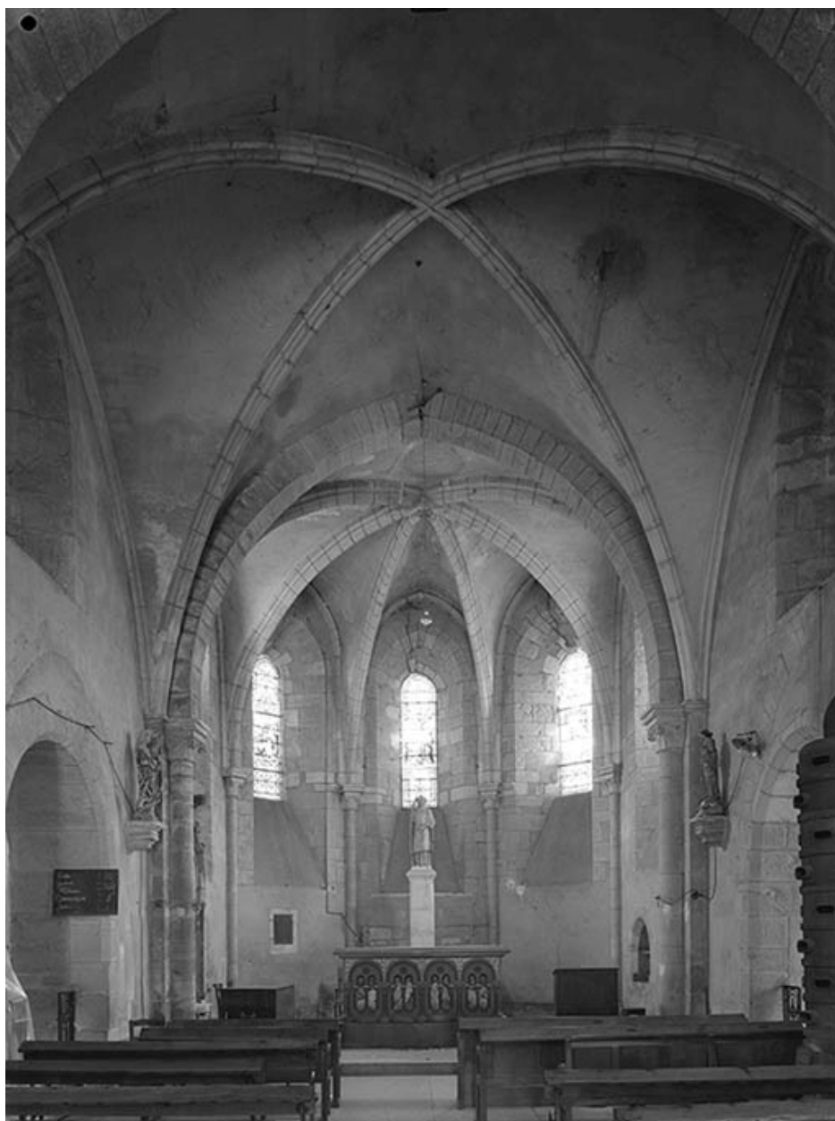
Vue intérieure vers le chœur, voûte d'ogives.
