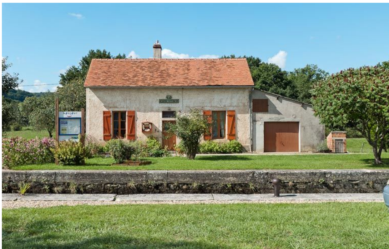
Vue de face de la maison éclusière.
