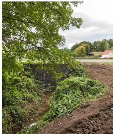
Vue de l'aqueduc.
