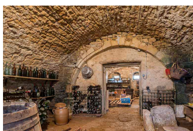
Cave voûtée, ferme de la Grande Vigne. Phot. Jérôme Mongreville IVR43_20187000035NUC4A
