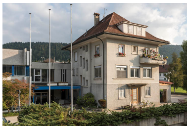
Hall d'entrée de 1970 et logement-conciergerie d'origine. Phot. Sonia Dourlot IVR43_20162501216NUC4A
