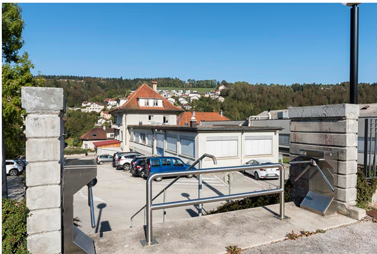
Entrée piétonne sur la rue des Gentianes.
