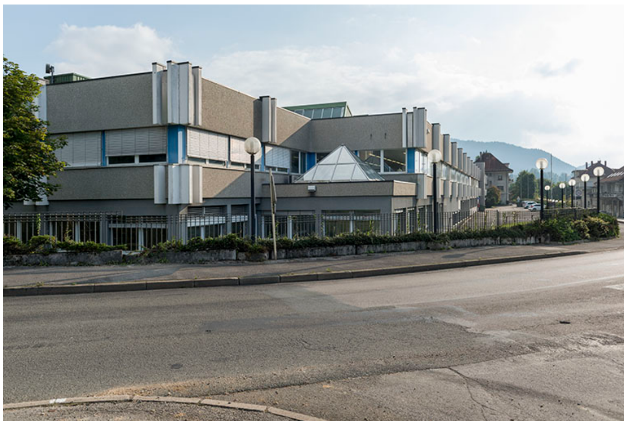
Façades nord et ouest.
