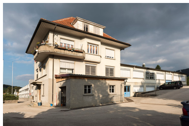
Logement-conciergerie et atelier de fabrication d'origine. Phot. Sonia Dourlot IVR43_20162501215NUC4A
