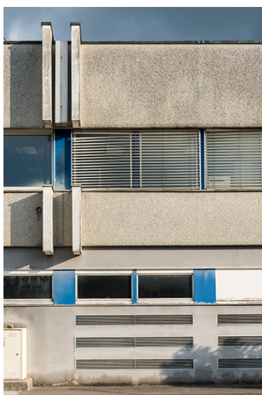
Façade ouest : une travée de l'atelier de 1970. Phot. Sonia Dourlot IVR43_20162501206NUC4A
