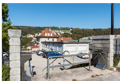
Entrée piétonne sur la rue des Gentianes.
