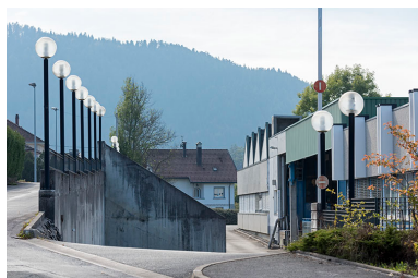
Façade est (côté rue des Gentianes). Phot. Sonia Dourlot IVR43_20162501210NUC4A
