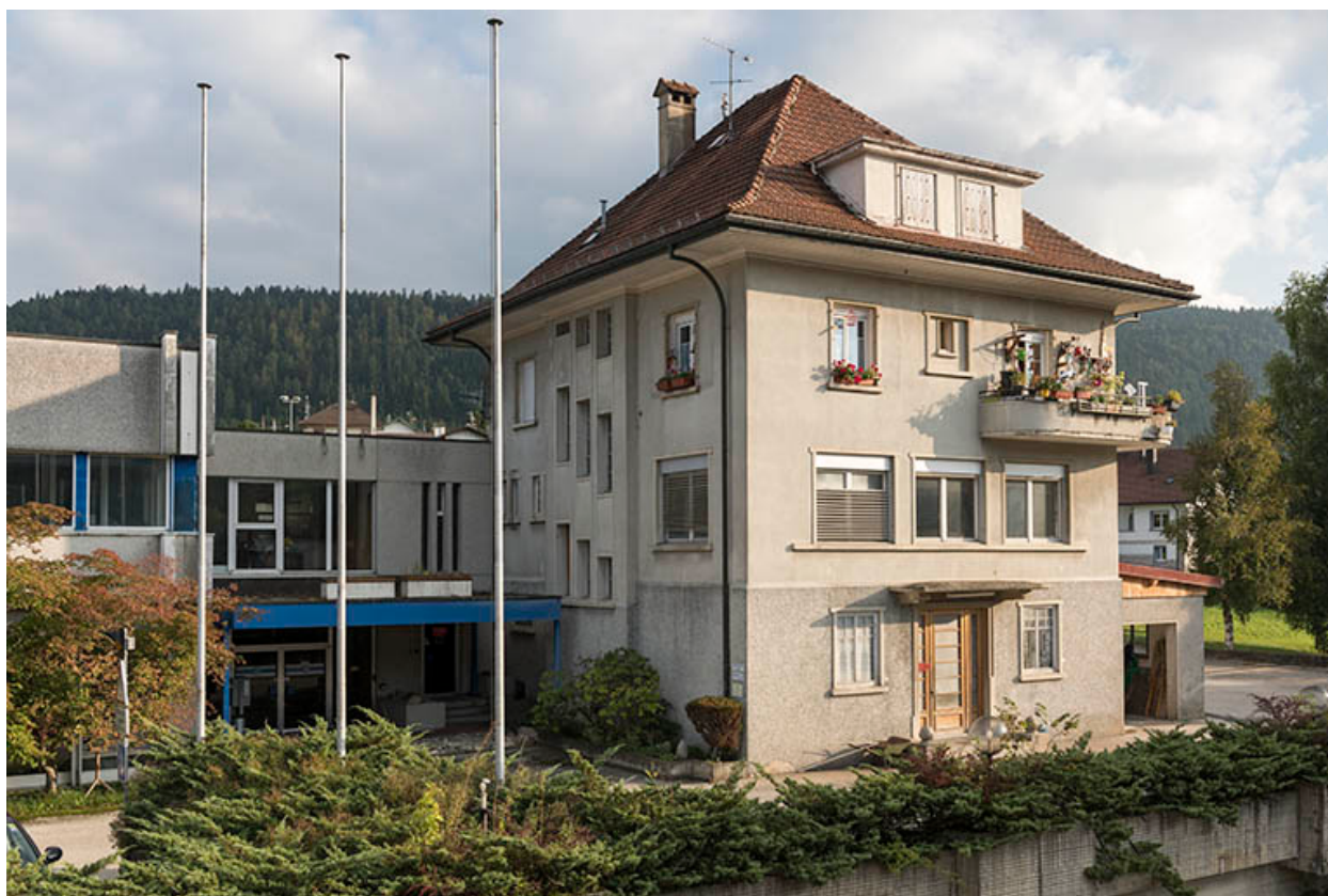
Hall d'entrée de 1970 et logement-conciergerie d'origine.
