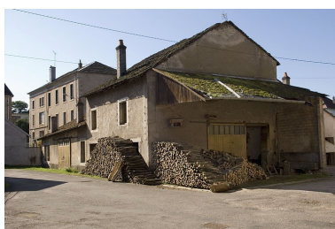
Atelier de fabrication sud. Phot. Jérôme Mongreville IVR43_20067000840NUCA
