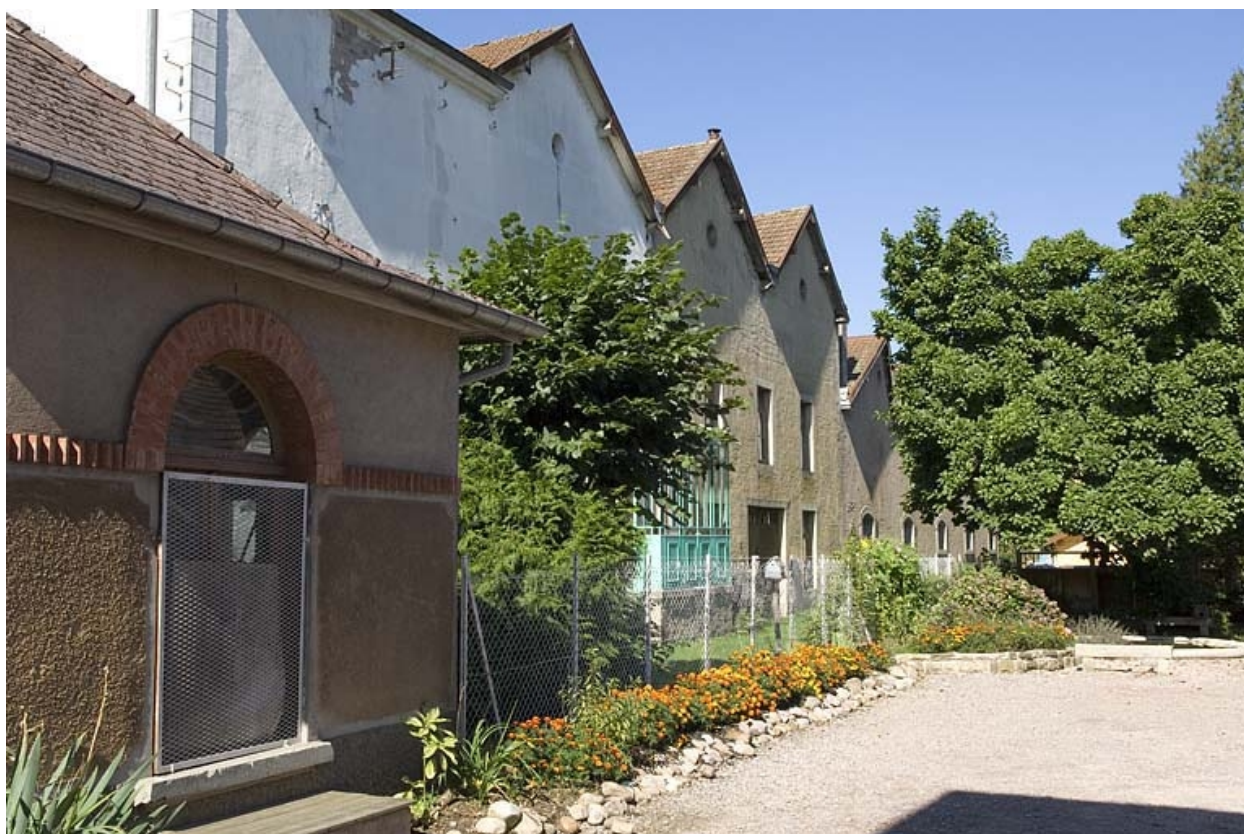
Façade postérieure de l'atelier de fabrication nord.
