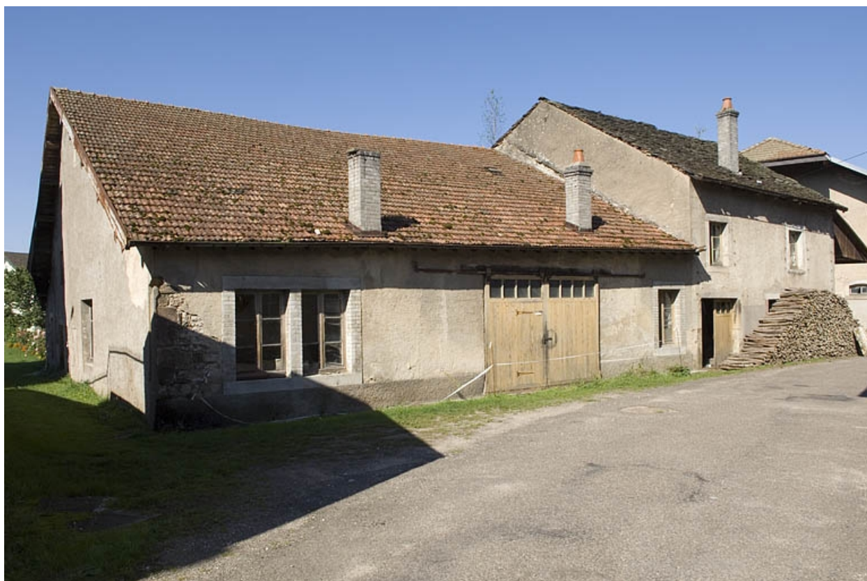
Atelier de fabrication sud. Vue depuis l'entrée.
