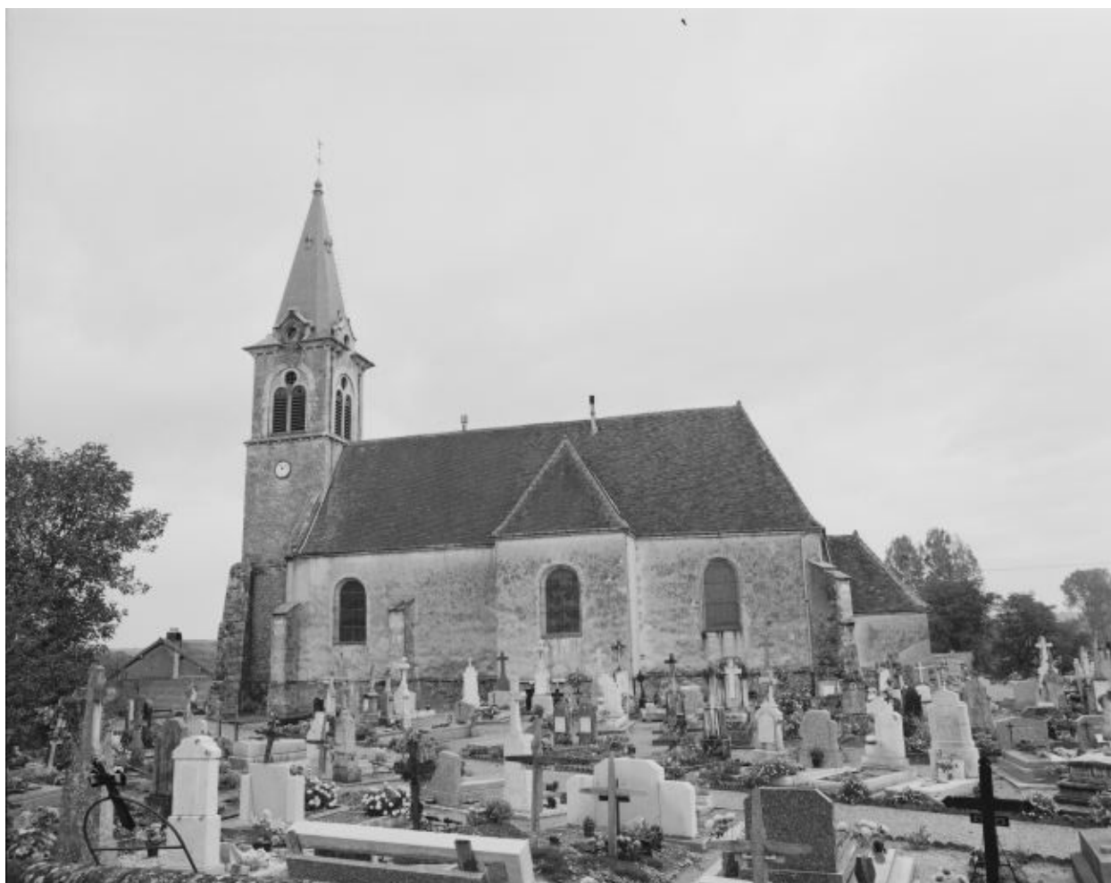
Façade latérale droite.
