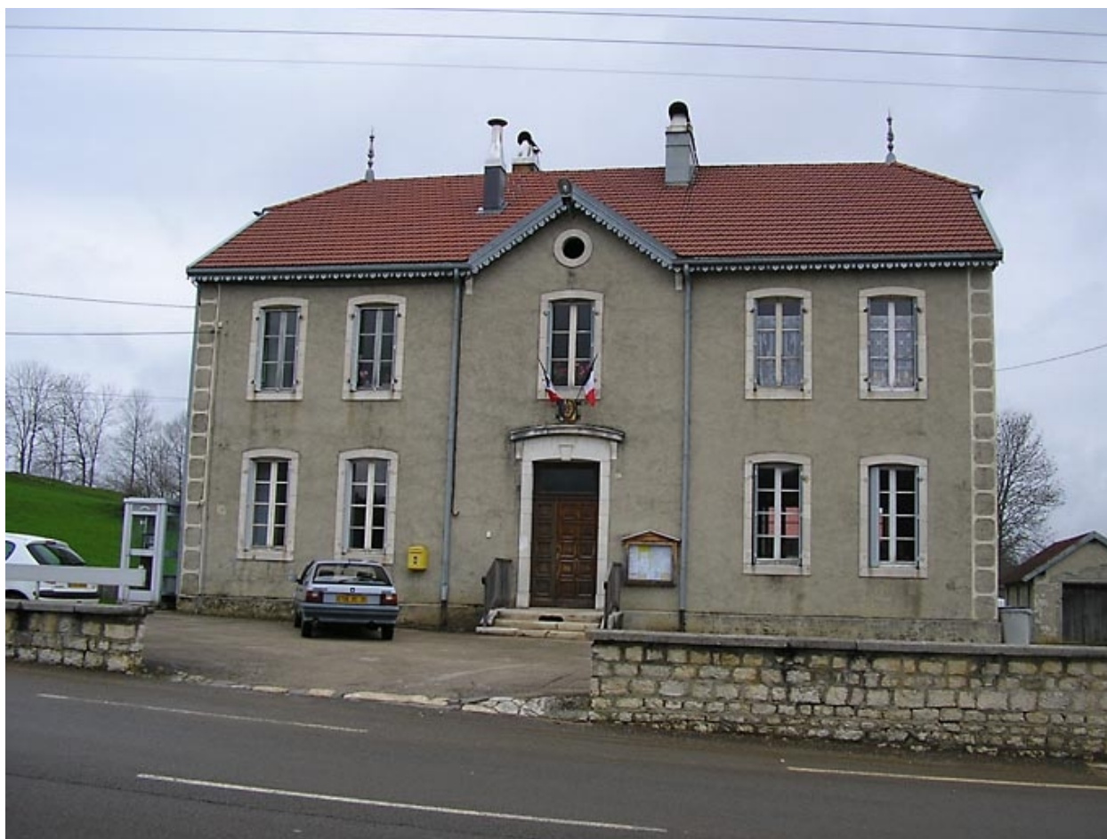
Vue générale de la façade antérieure.
