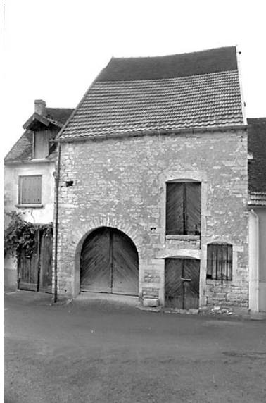
Façade rue des Fossés. Phot. Bernard Lardière IVR43_19817000844Z
