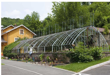
La serre. Phot. Jérôme Mongreville IVR43_20112501316NUC4A
