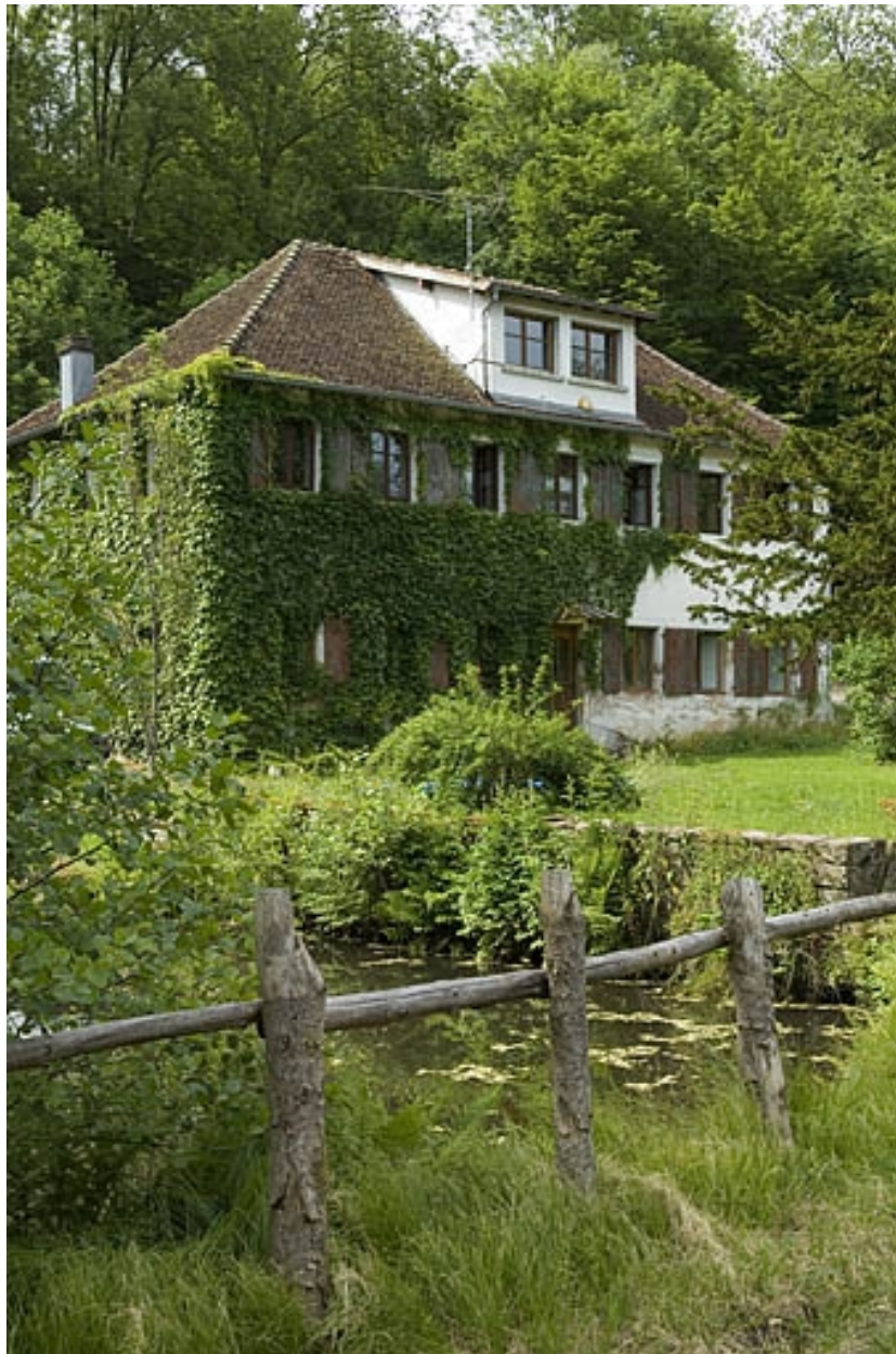
Ancienne saboterie, actuellement logement.
