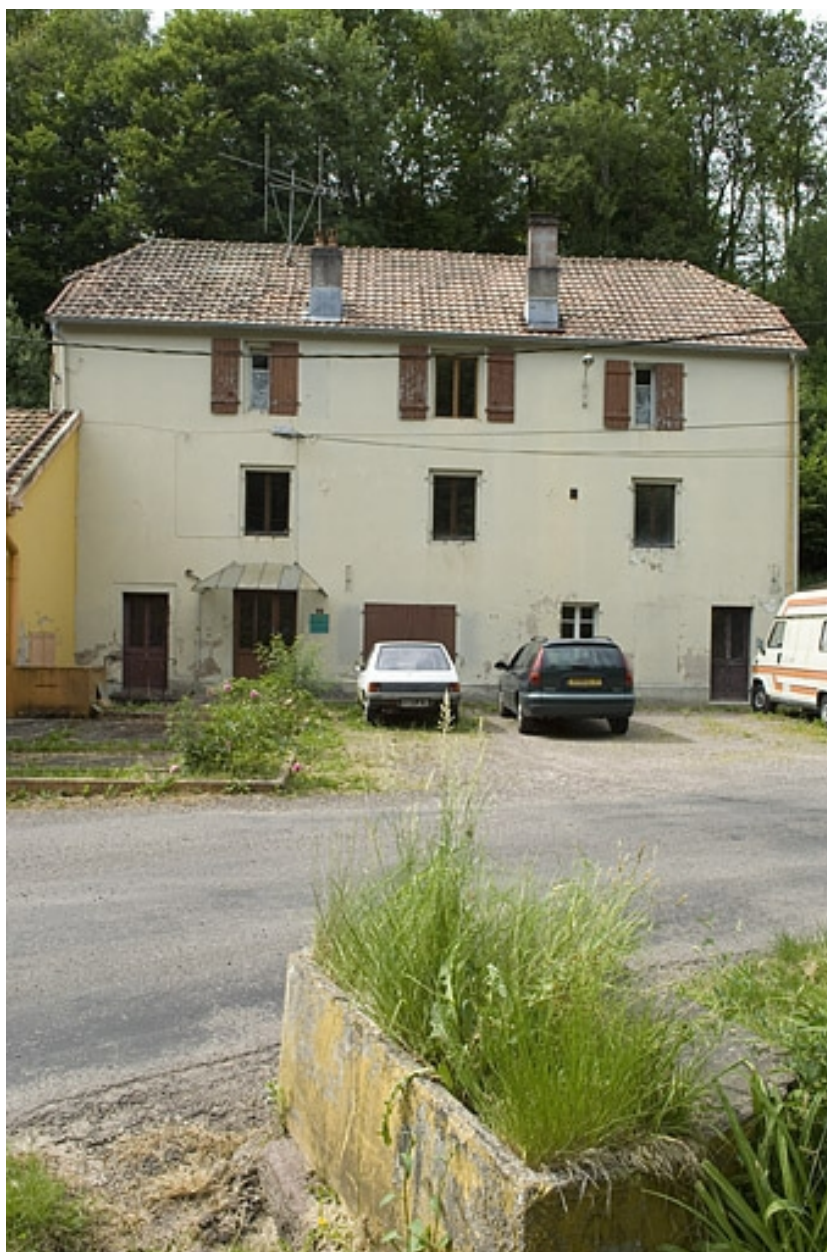
Façade antérieure de l'ancienne saboterie.
