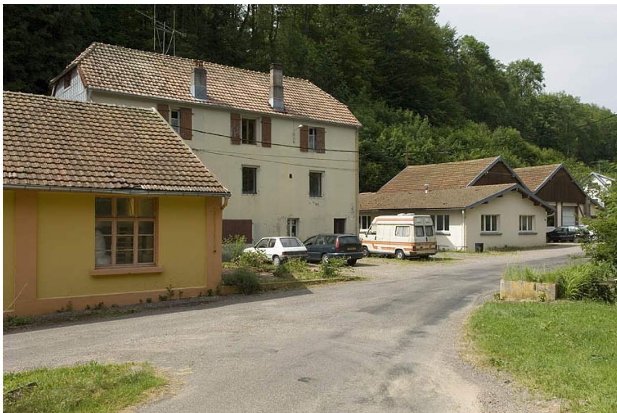
Ateliers de fabrication et de réparation.
