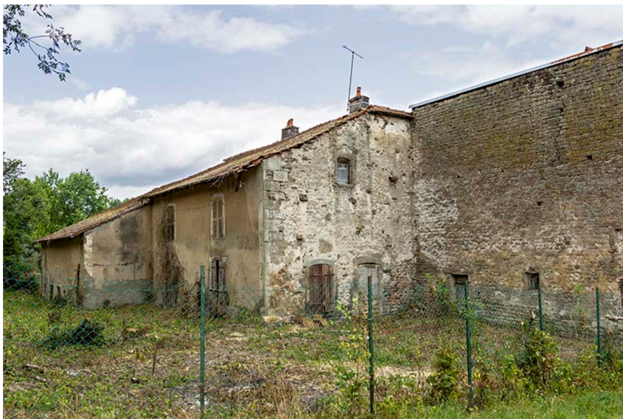
Vue générale sur la façade postérieure.
