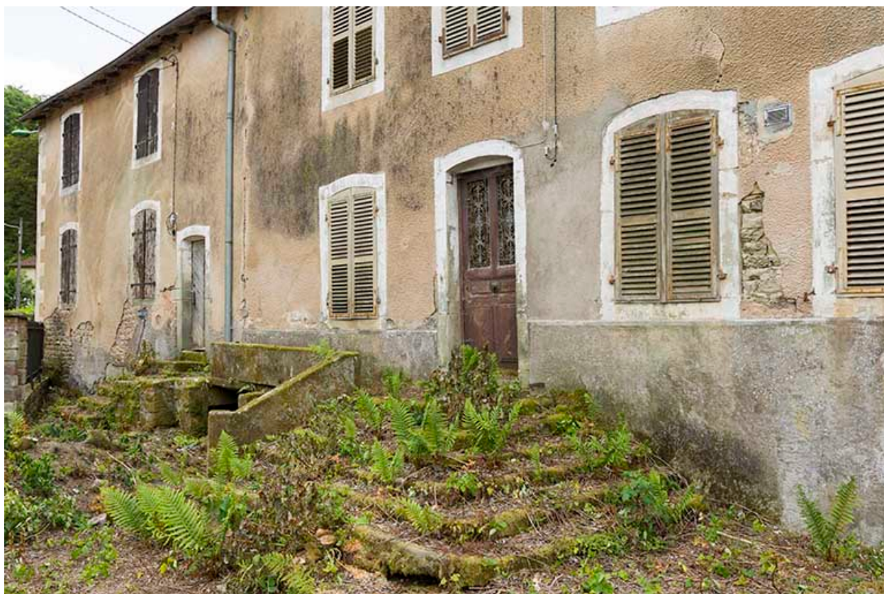
Vue sur la façade antérieure, partie habitation.
