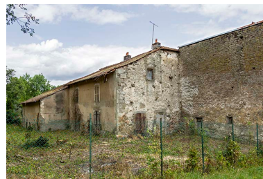
Vue générale sur la façade postérieure. Phot. Sonia Dourlot IVR43_20157000671NUC2A
