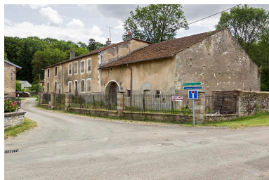
Vue générale. Phot. Sonia Dourlot IVR43_20157000669NUC2A
