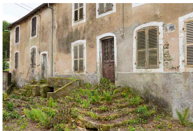
Vue sur la façade antérieure, partie habitation. Phot. Sonia Dourlot IVR43_20157000673NUC2A
