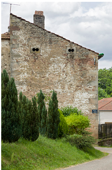
Mur pignon avec ses petits oculis. Phot. Sonia Dourlot IVR43_20157000670NUC2A
