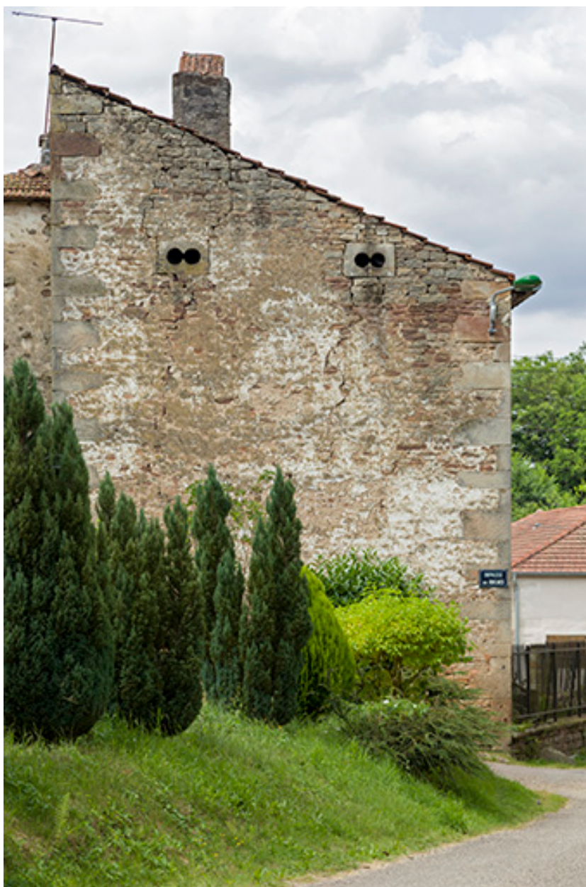
Mur pignon avec ses petits oculis.
