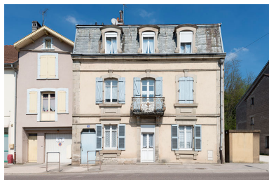
Façade antérieure. Phot. Jérôme Mongreville IVR43_20177000486NUC4A
