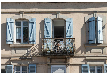
Étage carré, façade antérieure. Phot. Jérôme Mongreville IVR43_20177000988NUC4A
