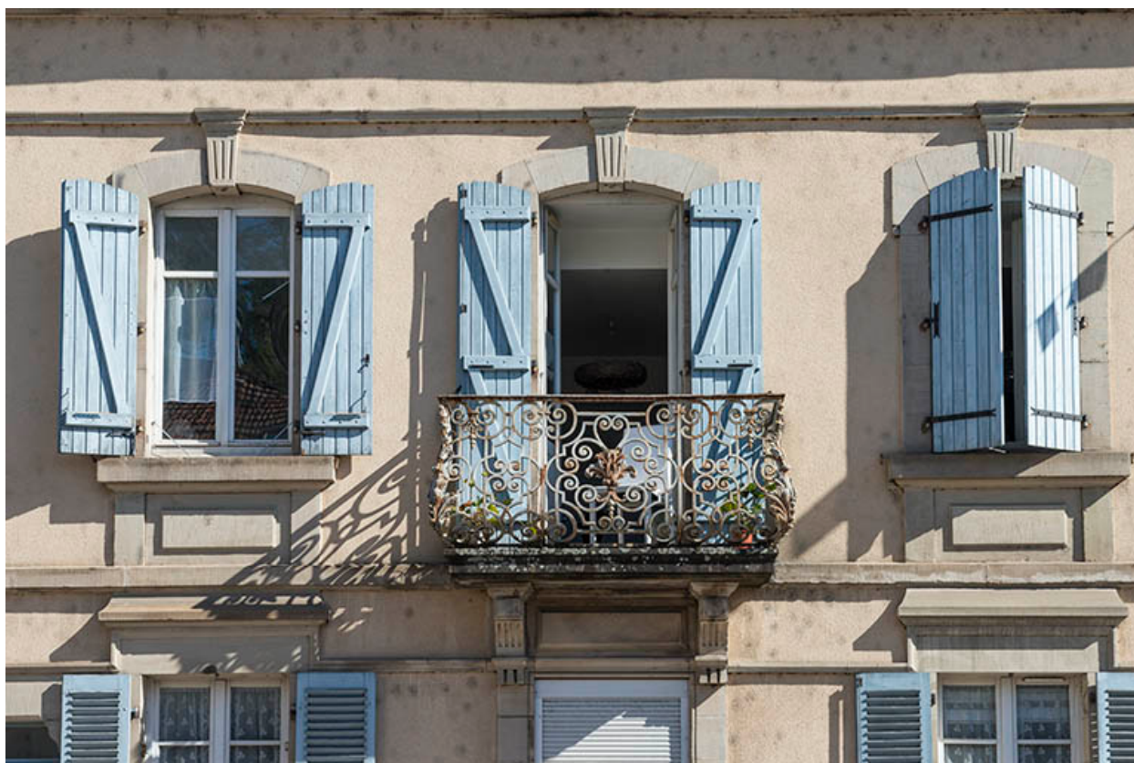
Etage carré, façade antérieure.
