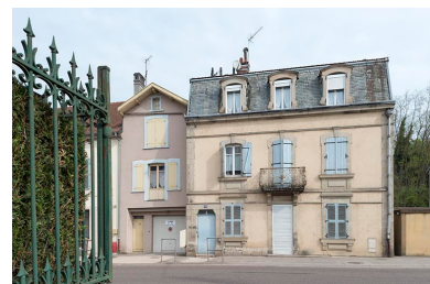
Vue générale. Phot. Jérôme Mongreville IVR43_20177000472NUC4A
