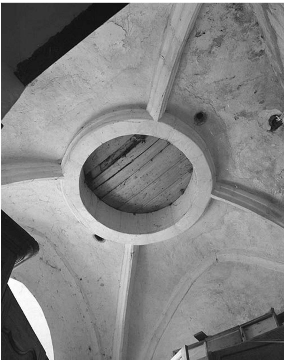
Clocher, niveau inférieur : voûte.
