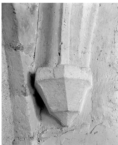
Clocher, niveau inférieur : culot postérieur gauche. IVR26_19728901101X
