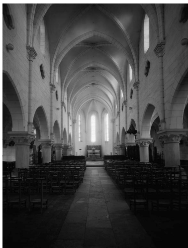
Nef et chœur. Phot. non renseigné IVR26_19728901078V
