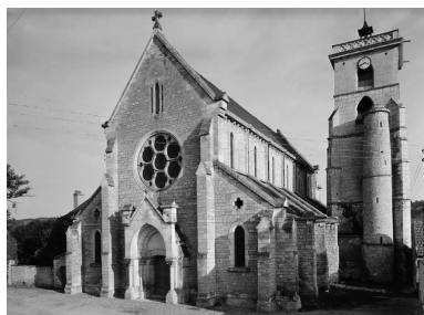
Façade et élévation droite. Phot. non renseigné IVR26_19728901083V
