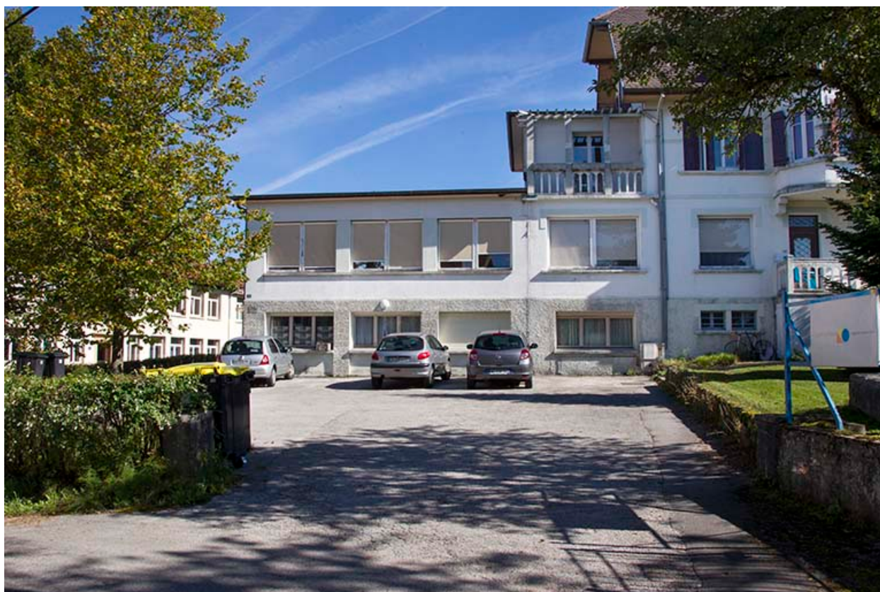
Usine : façade antérieure.
