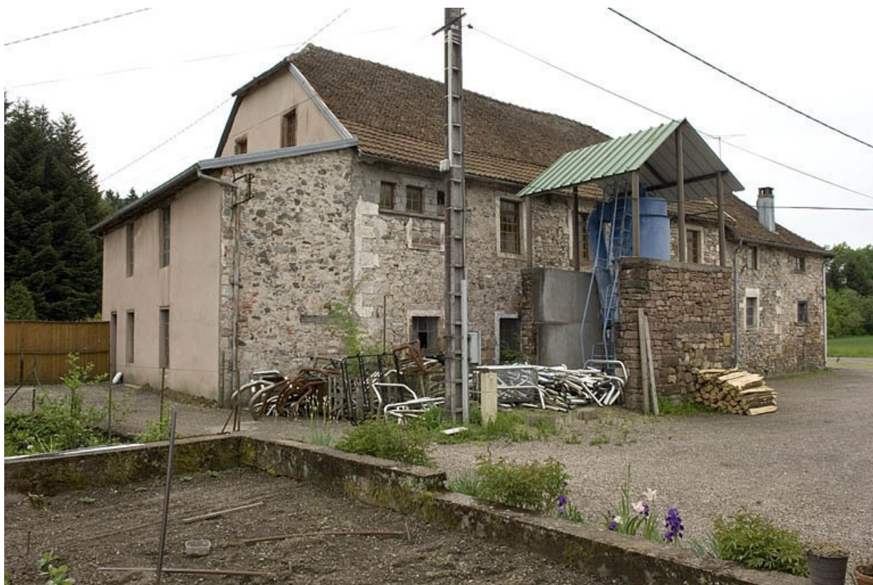
Façade nord de l'atelier de filature.
