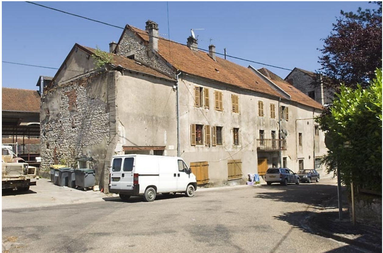
Bâtiment des bureaux et logement.
