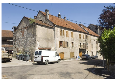
Bâtiment des bureaux et logement.
