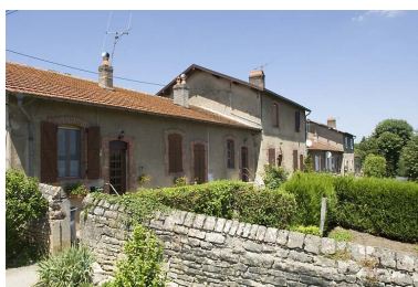
Logements ouvriers contigus. Vue depuis le sud-est. Phot. Jérôme Mongreville IVR43_20087000872NUC2A
