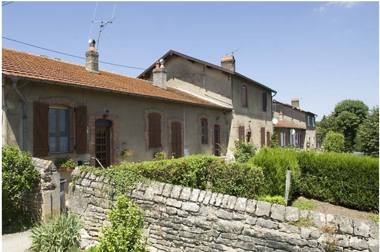
Logements ouvriers contigus. Vue depuis le sud-est.
