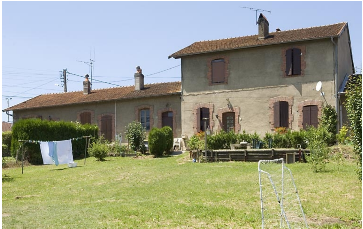
Logements ouvriers depuis l'ouest.
