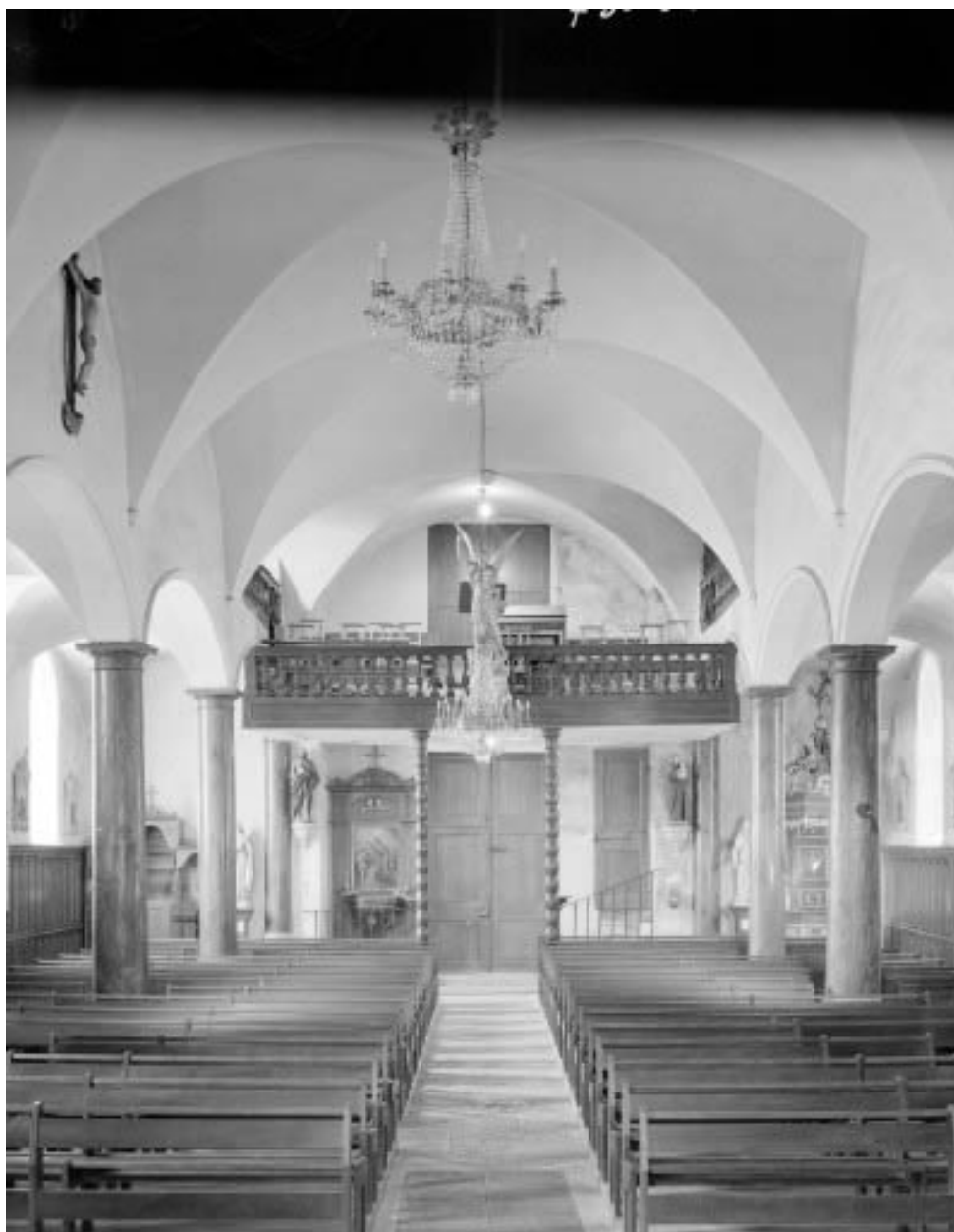
Intérieur : vue d'ensemble depuis le chœur.
