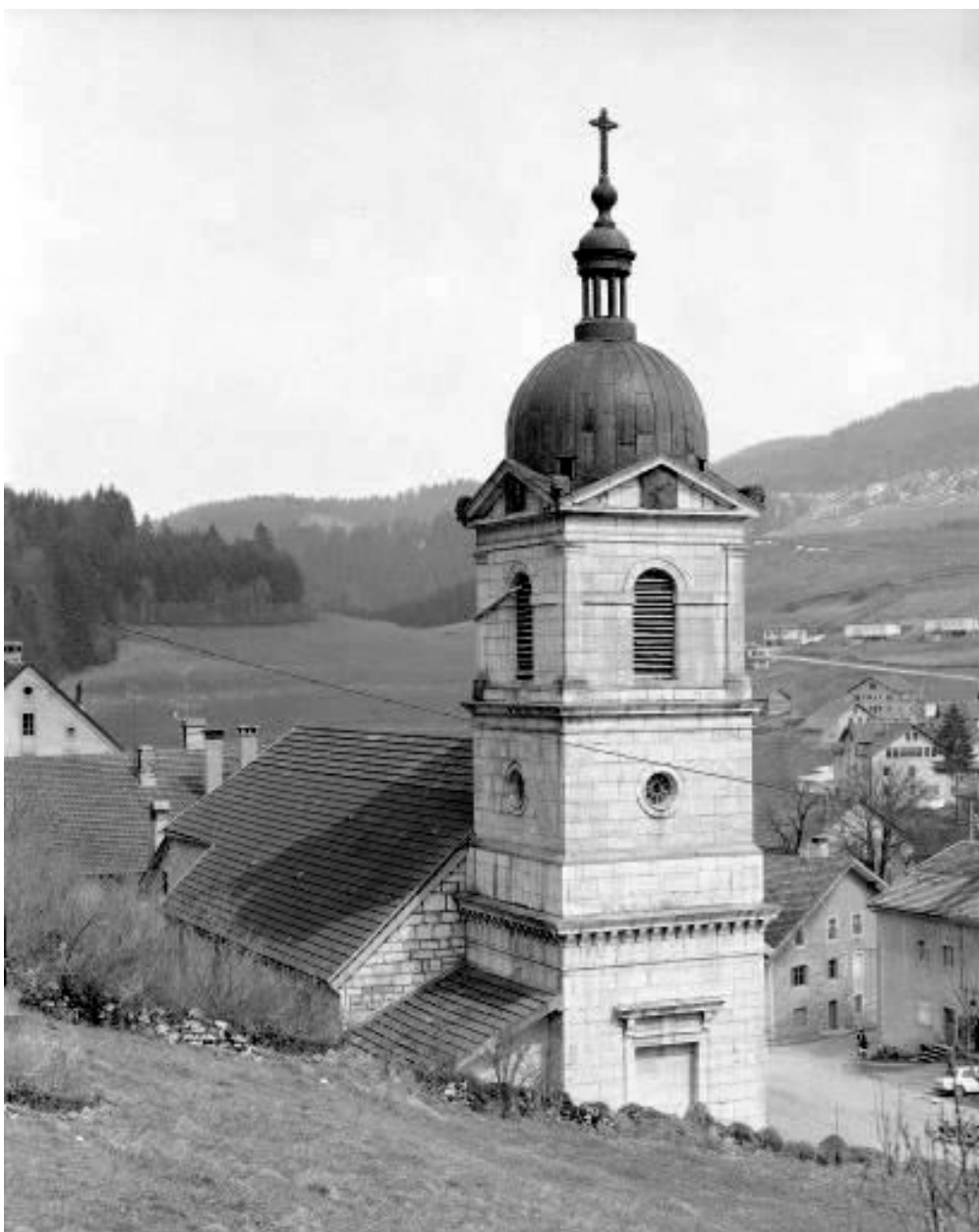
Extérieur : façade antérieure.
