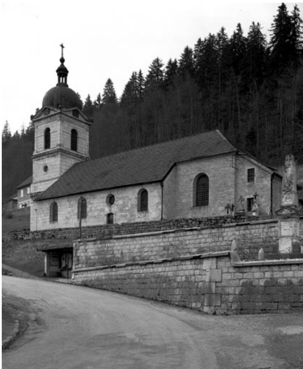
Façade latérale sud.
