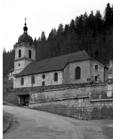
Façade latérale sud.
