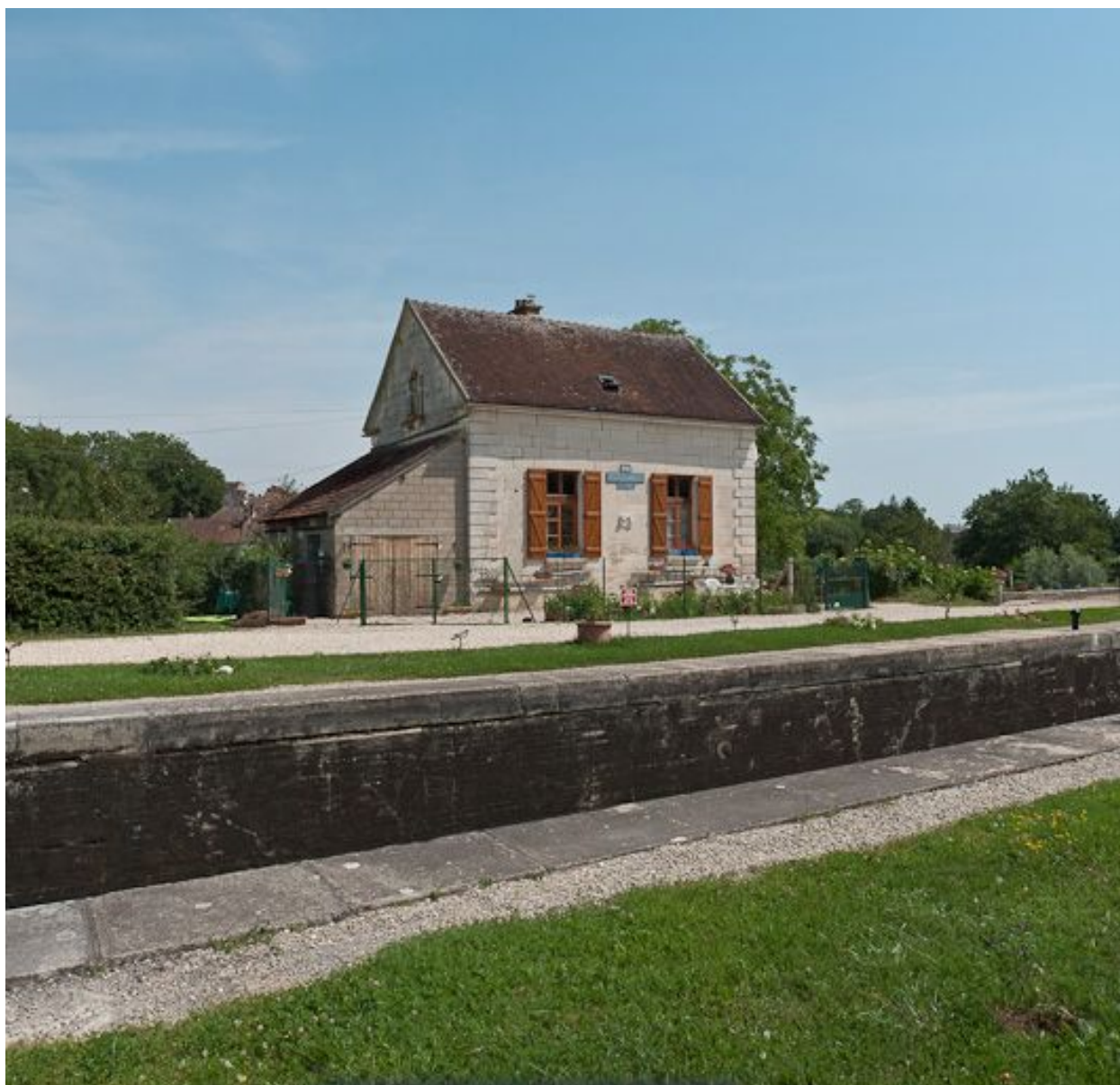
Vue de la maison éclusière.
