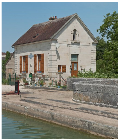
Vue de la maison éclusière. Phot. Pierre-Marie Barbe-Richaud IVR26_20118900379NUC2AQ
