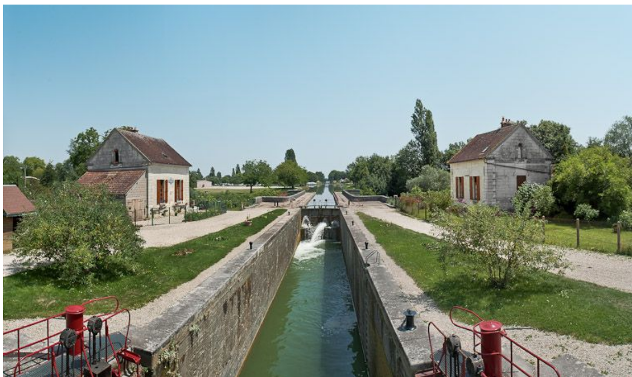
Vue d'ensemble du site d'écluse.
