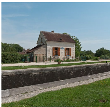
Vue de la maison éclusière. Phot. Pierre-Marie Barbe-Richaud IVR26_20118900375NUC2AQ
