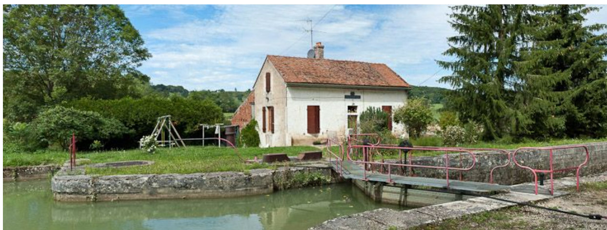
Vue d'ensemble du site d'écluse.
