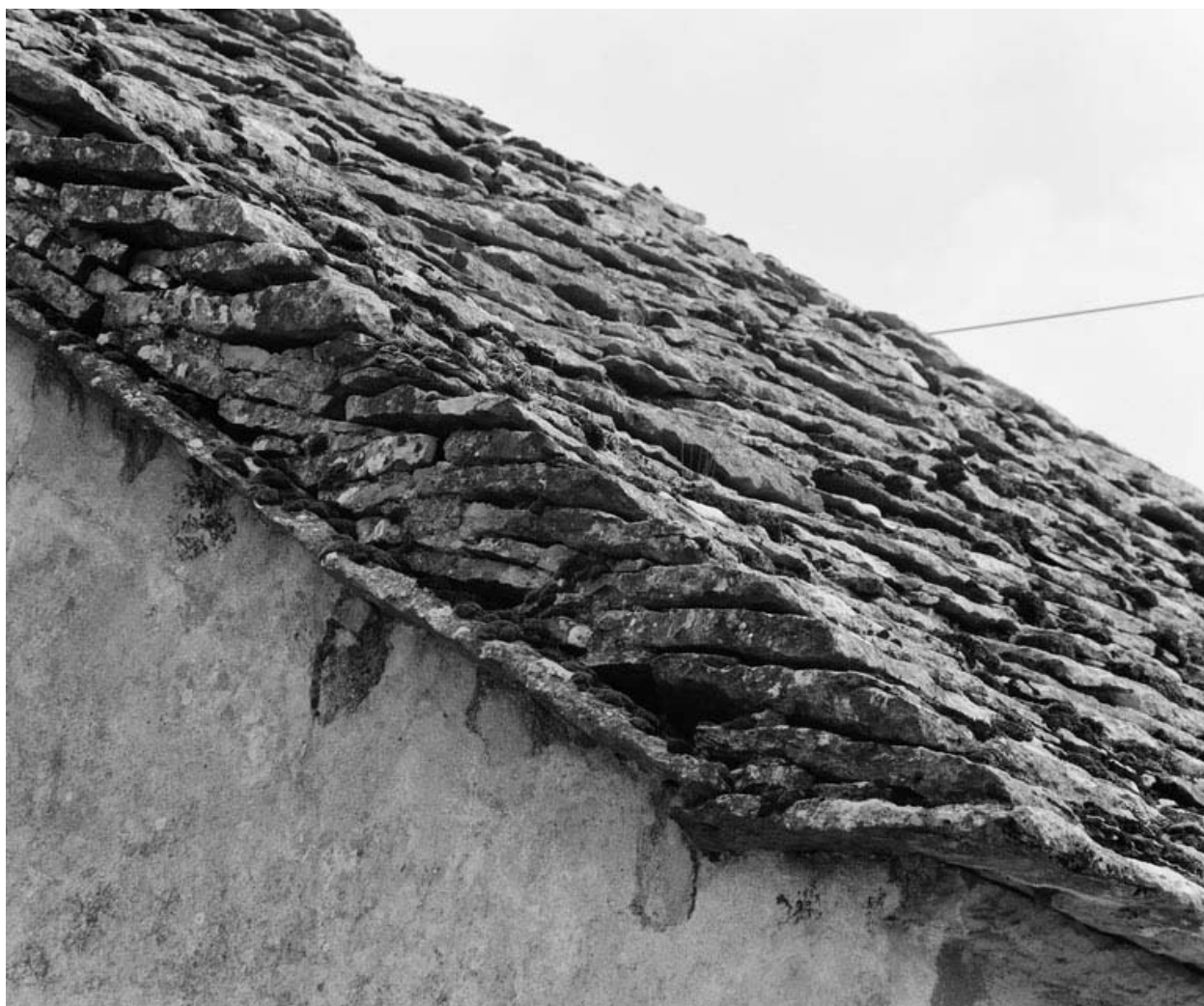
Détail du toit.
