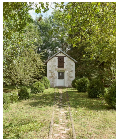
Vue de l'annexe agricole. Phot. Pierre-Marie Barbe-Richaud IVR26_20178900188NUC2A
