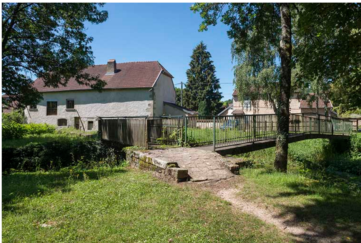
L'ancien moulin, rue du Petit Moulin.
