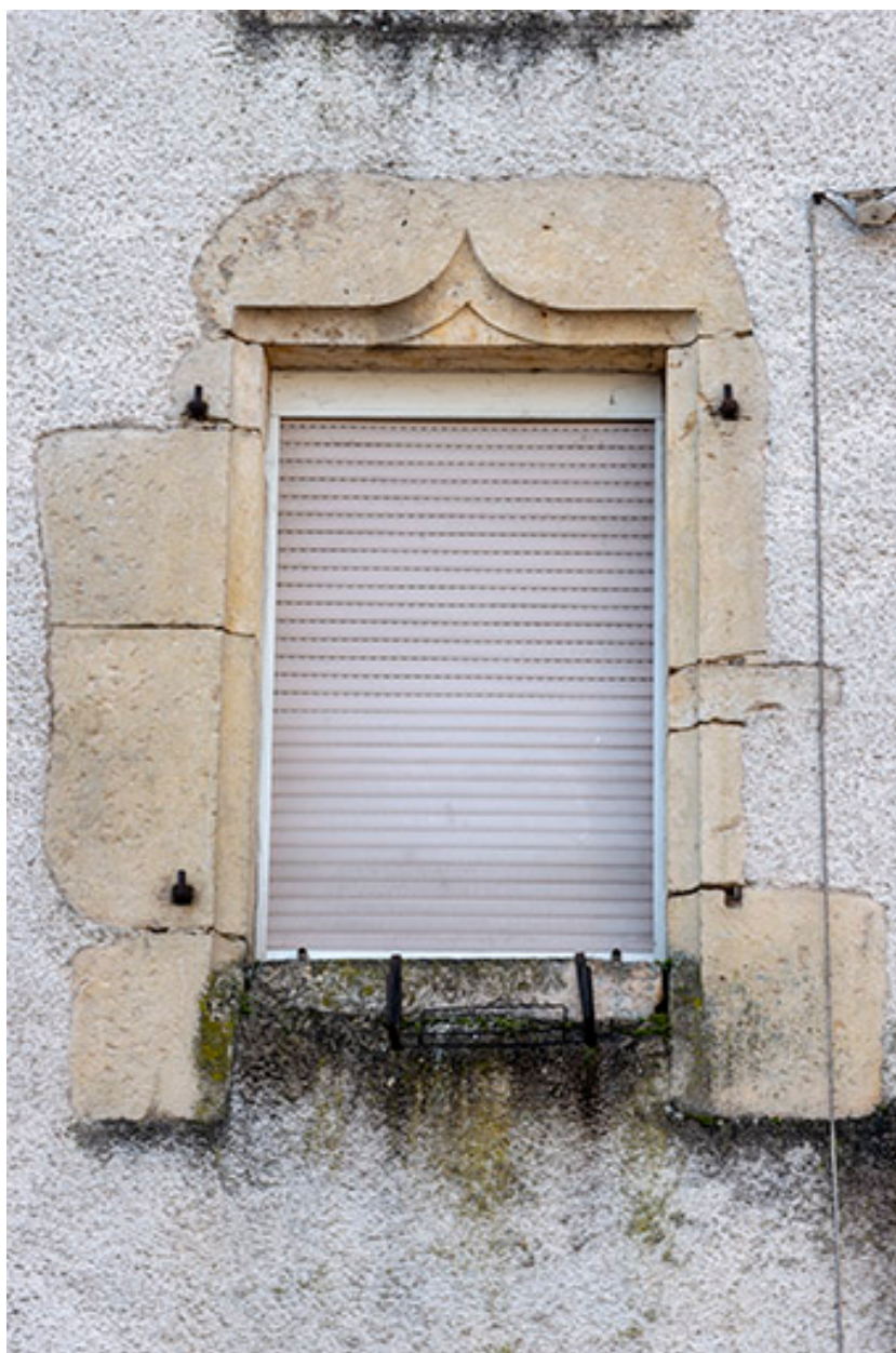
Fenêtre avec linteau en accolade.
