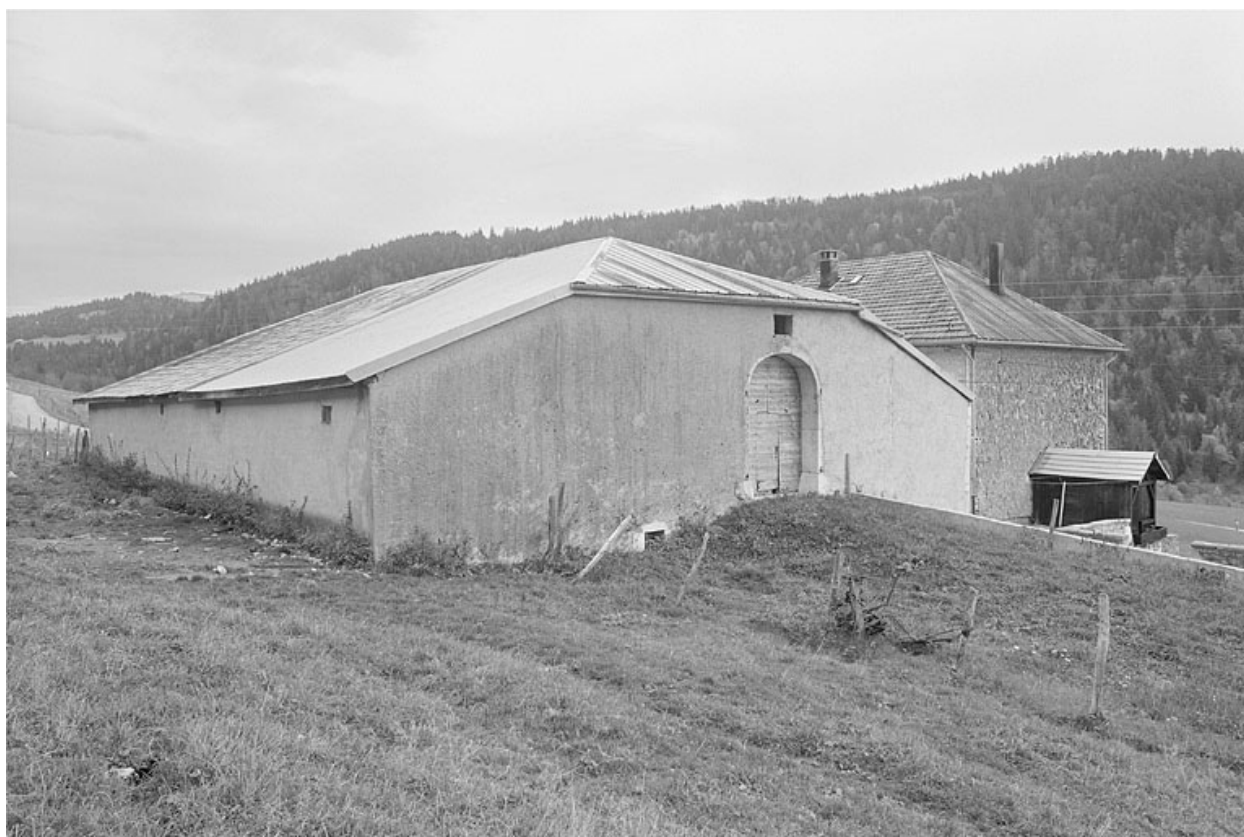
Face sud-ouest et façade postérieure.
