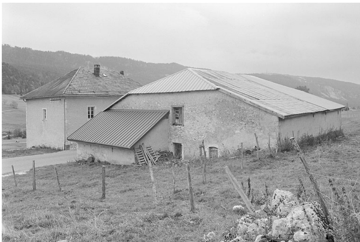
Façade postérieure et face nord-est.
