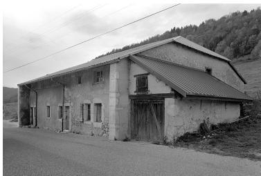
Façade antérieure et face nord-est. Phot. Jérôme Mongreville IVR43_19963901535X
