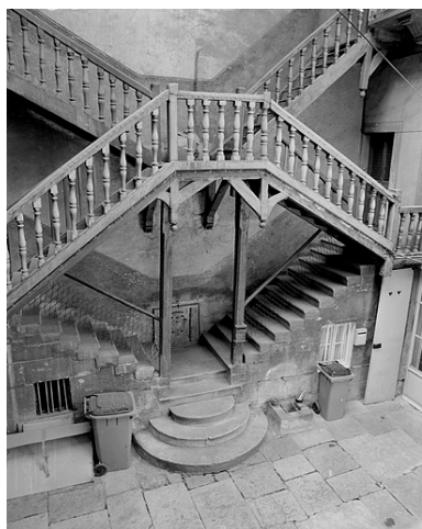
Escalier dans la cour. Phot. Yves Sancey IVR43_19833900191X
