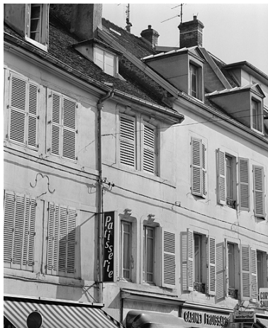
Façade antérieure, premier et deuxième étages. Phot. Yves Sancey IVR43_19853900328X
