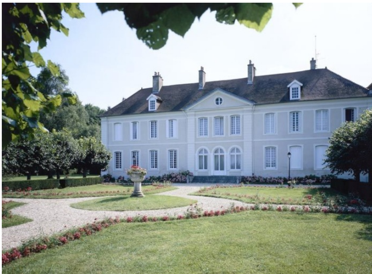
Façade sur Saône.
