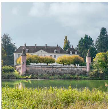
Le château de Pouilly, sa terrasse et les tourelles d'angle vus depuis le chemin de halage, rive gauche de la Saône. Phot. Thierry Kuntz IVR26_20172100498NUC4A
