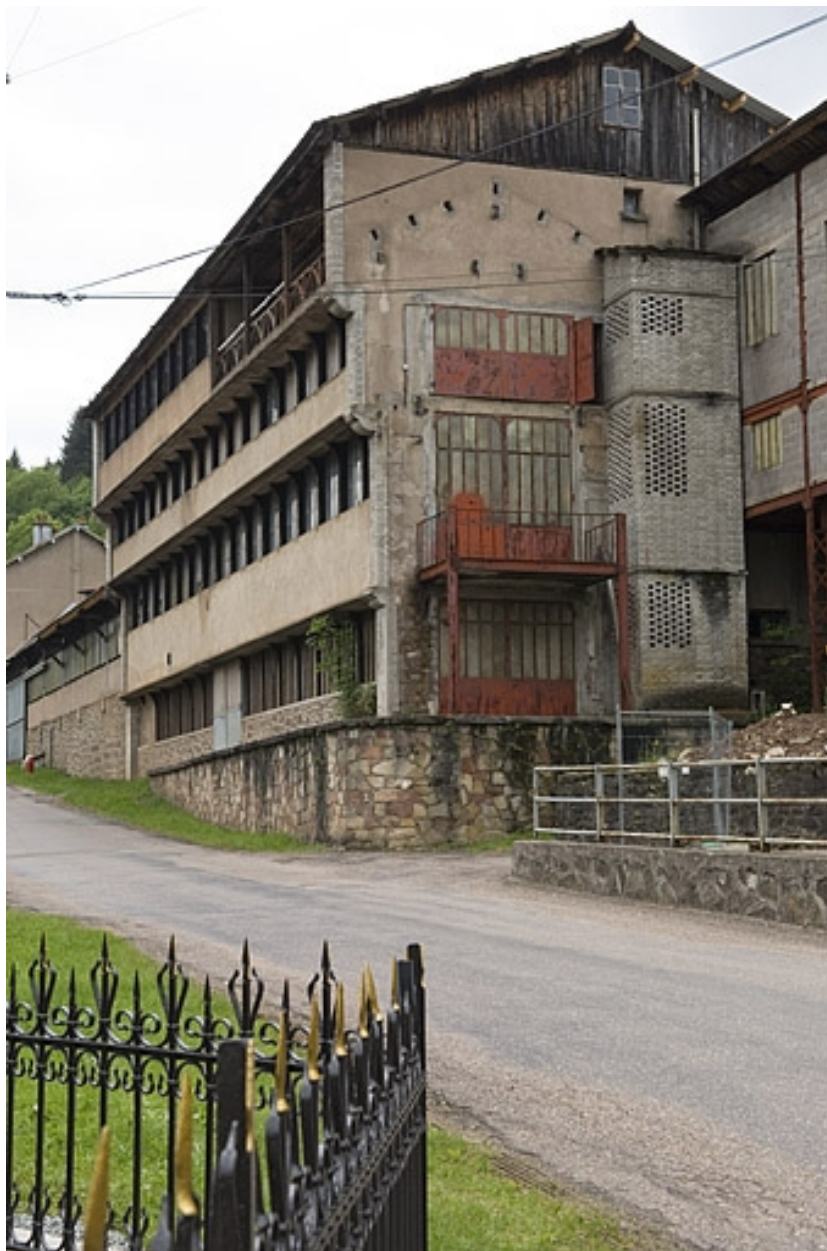
Elévation sud-est de l'atelier de fabrication primitif.
