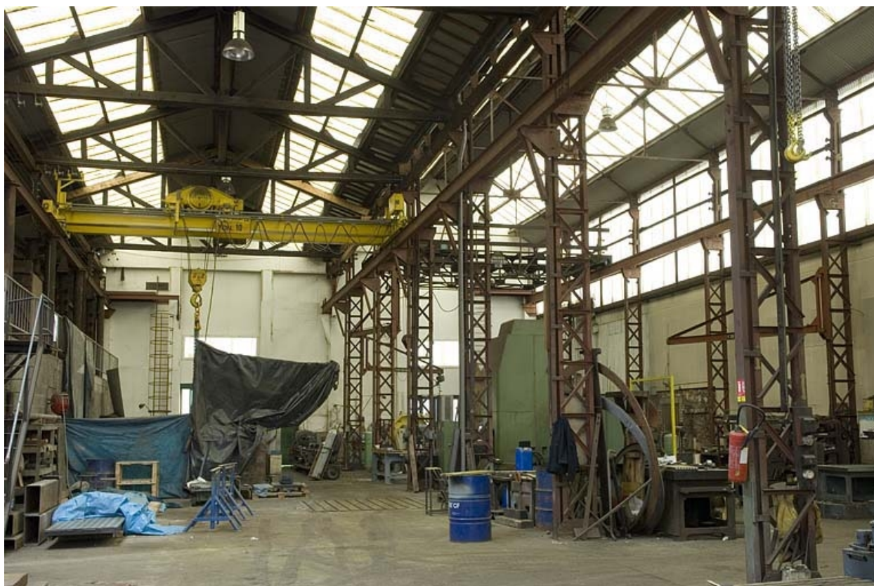
Atelier de mécanique. Structure et charpente métallique.
