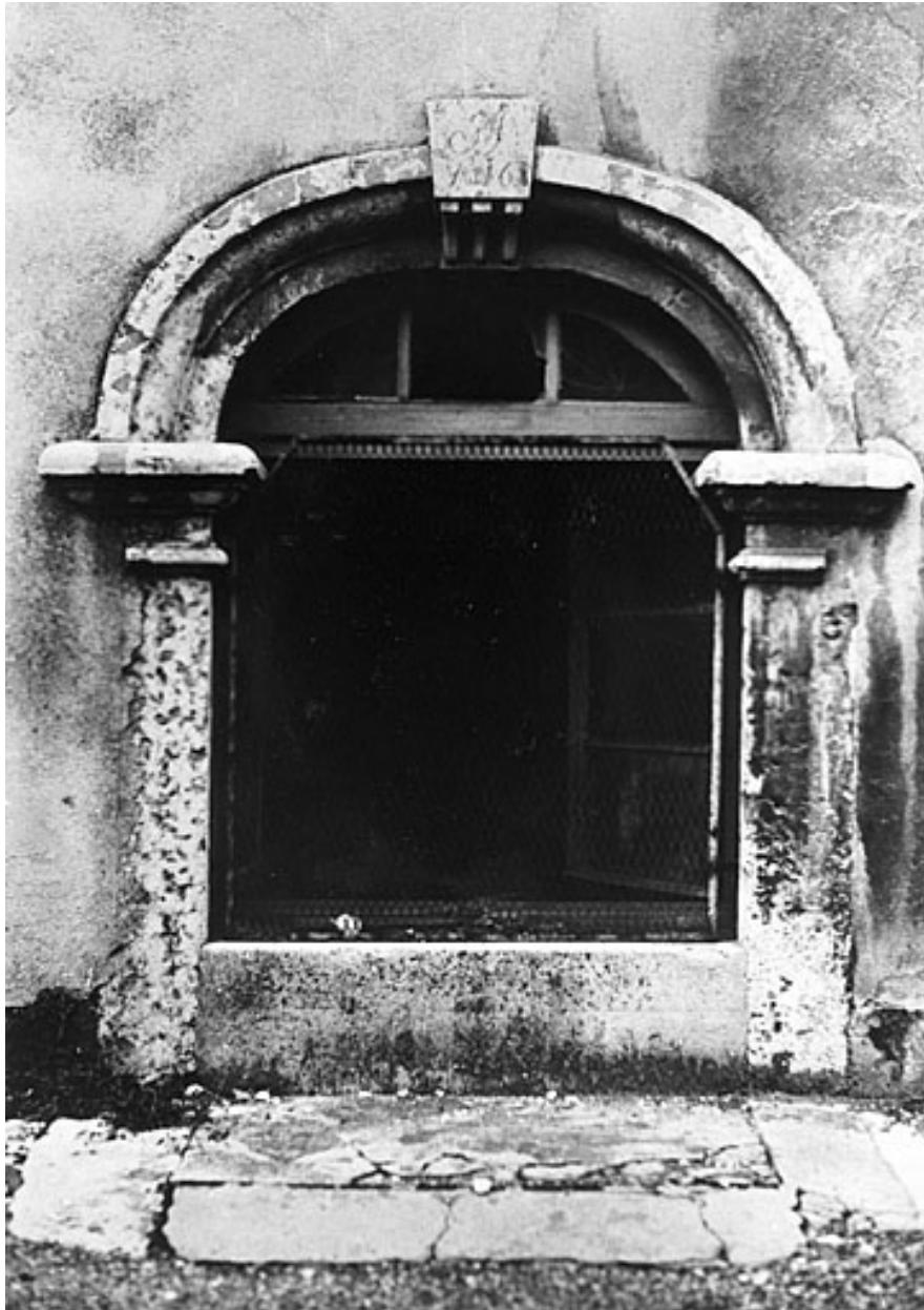
Baie sur la façade sud (état en 1978).
