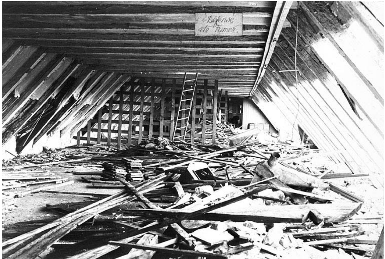
L'étage de comble (état en 1978).
