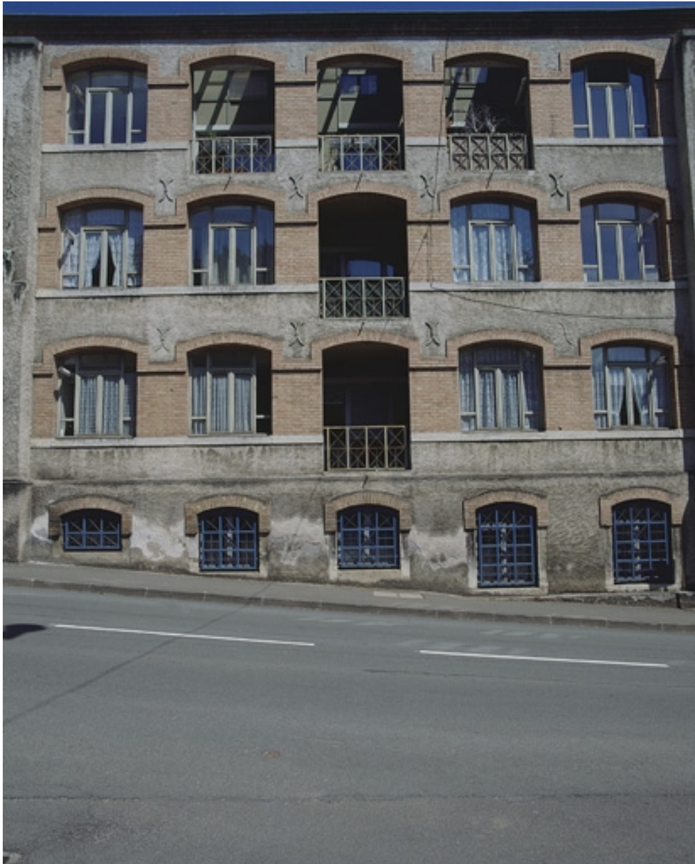
Travées de la façade antérieure.
