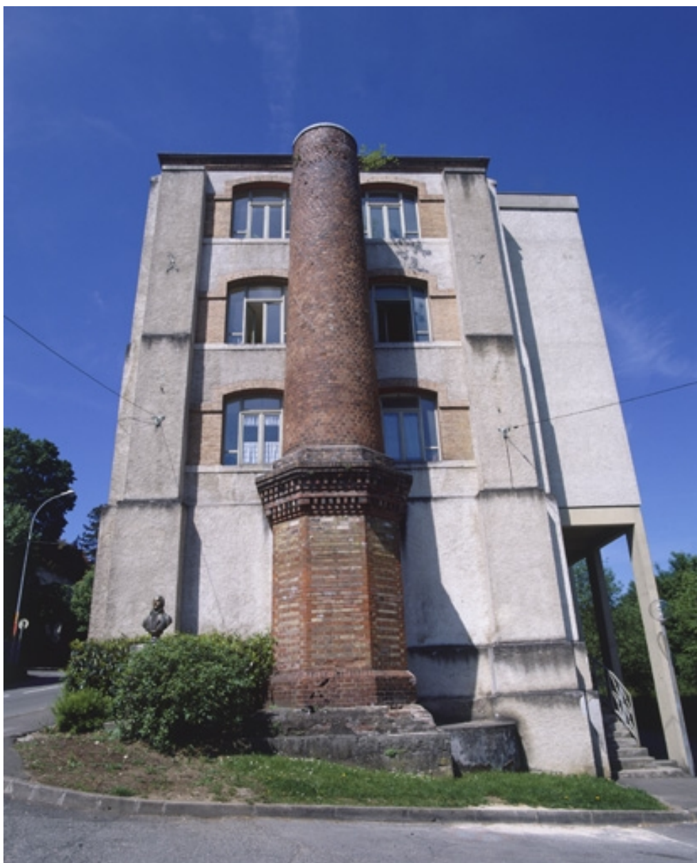
Façade est et cheminée (tronquée).
