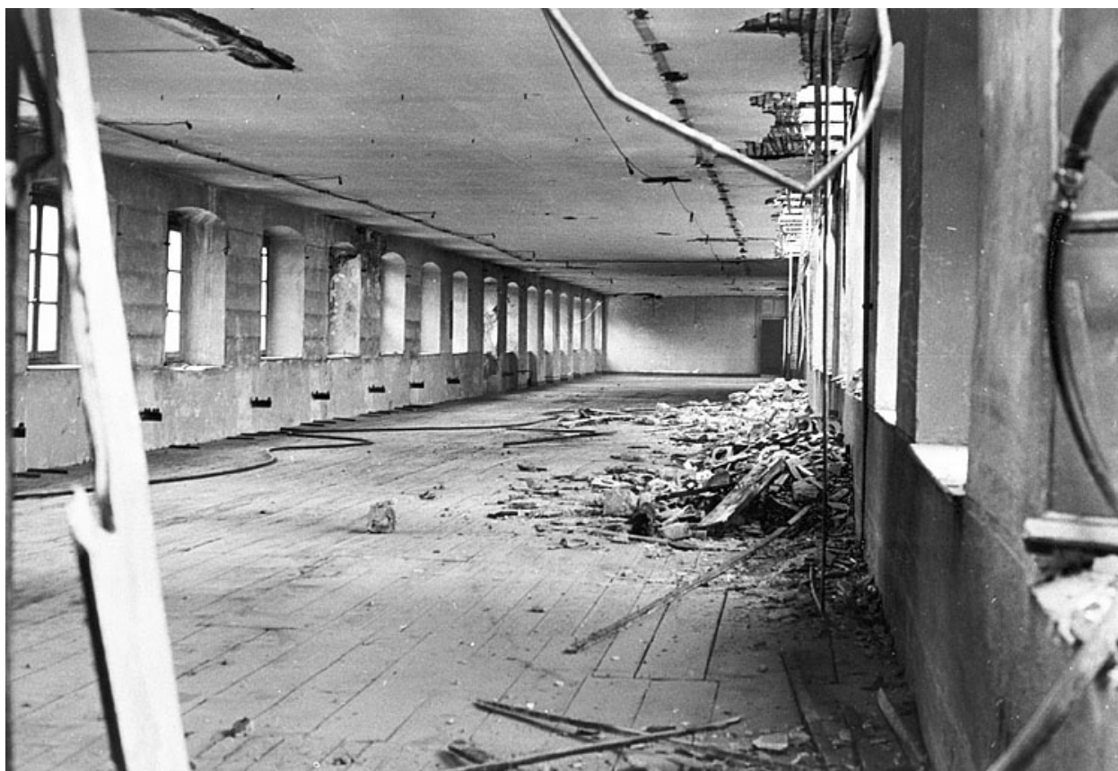
Atelier au second étage (état en 1978).
