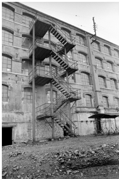
Extension des années 1892 : escalier métallique sur la façade postérieure (état en 1981).SRI. Enquête régionale sur les bâtiments industriels (1979-1981). Phot. Jack Dumont IVR43_19819000086Z
