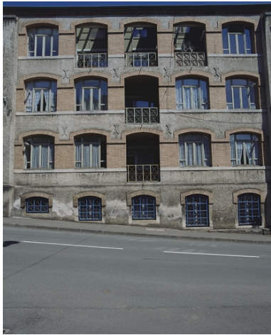
Travées de la façade antérieure.
