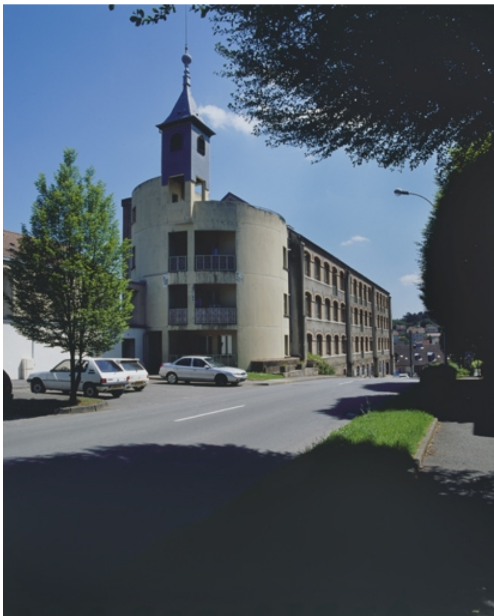
Extrémité ouest de l'atelier de fabrication.
