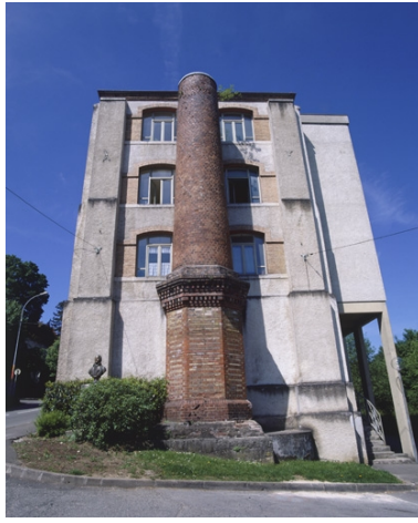
Façade est et cheminée (tronquée).
