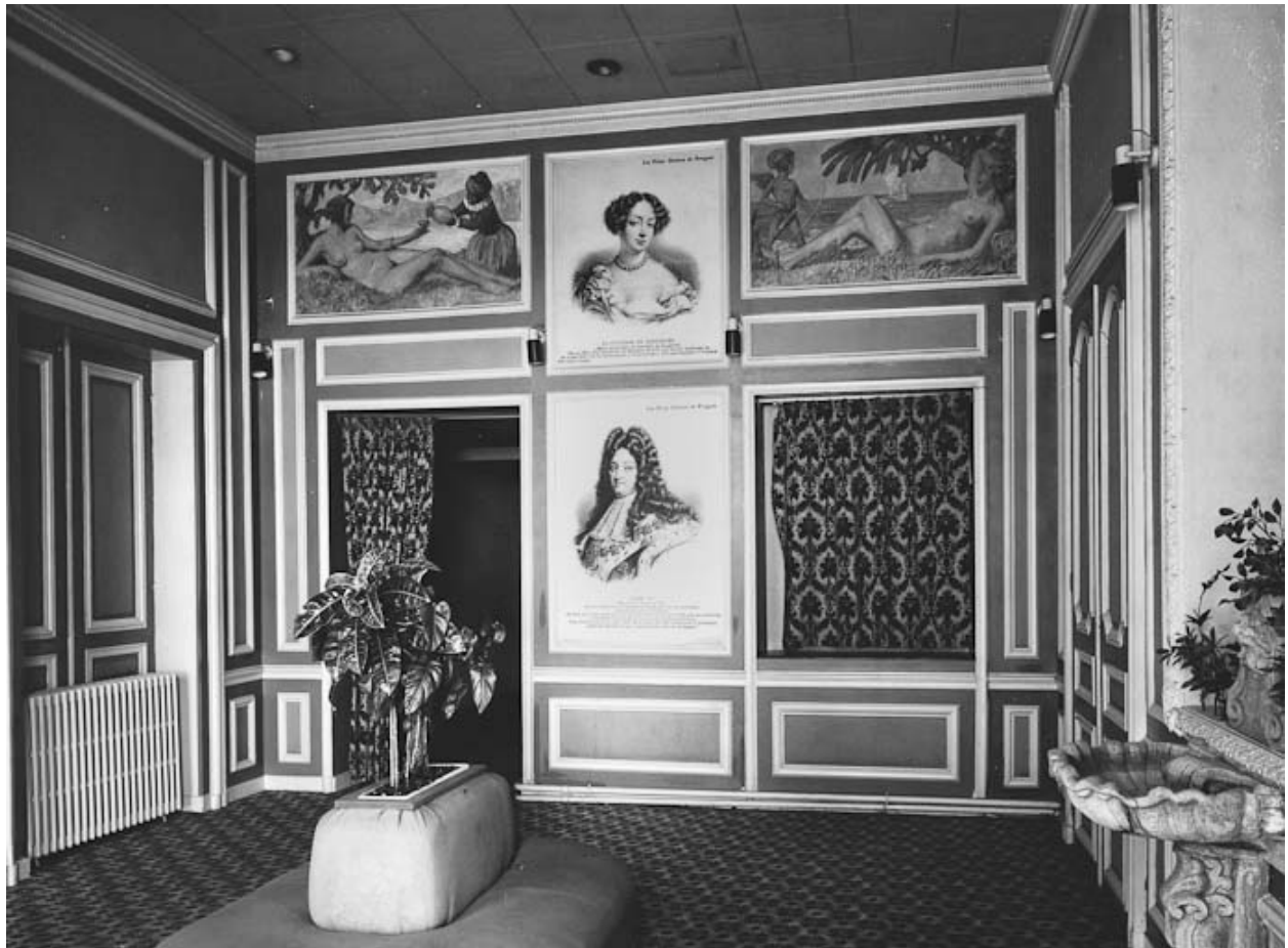
Vue intérieure du hall d'entrée (ancien foyer) en direction des vestiaires.
