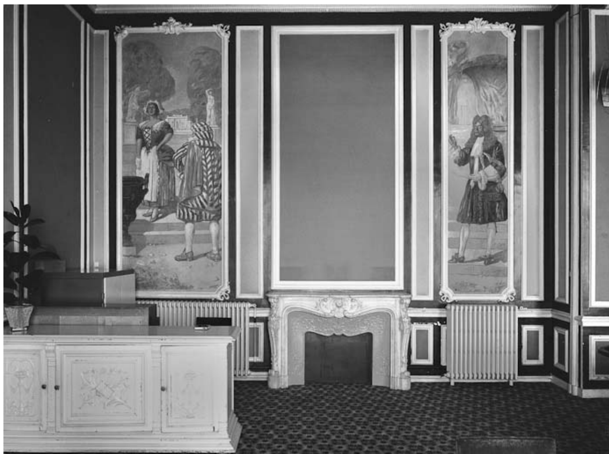
Vue de l'angle sud-est de l'ancienne salle du théâtre (partie transformée en salle de jeux) avec deux compositions peintes encore en place : scènes non identifiées.
