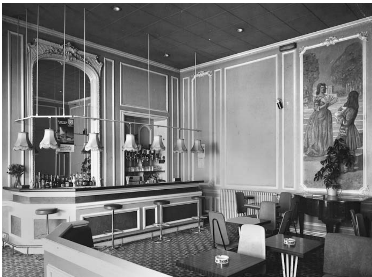
Vue de l'angle nord-est de l'ancienne salle du théâtre (partie transformée en bar) avec une composition peinte encore en place : la Conversation.
