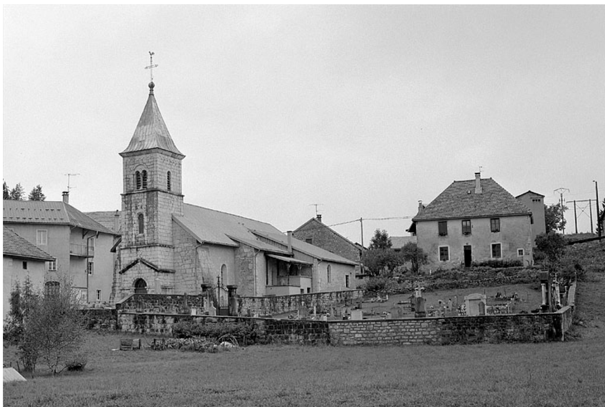
Extérieur : vue générale depuis le sud-ouest.
