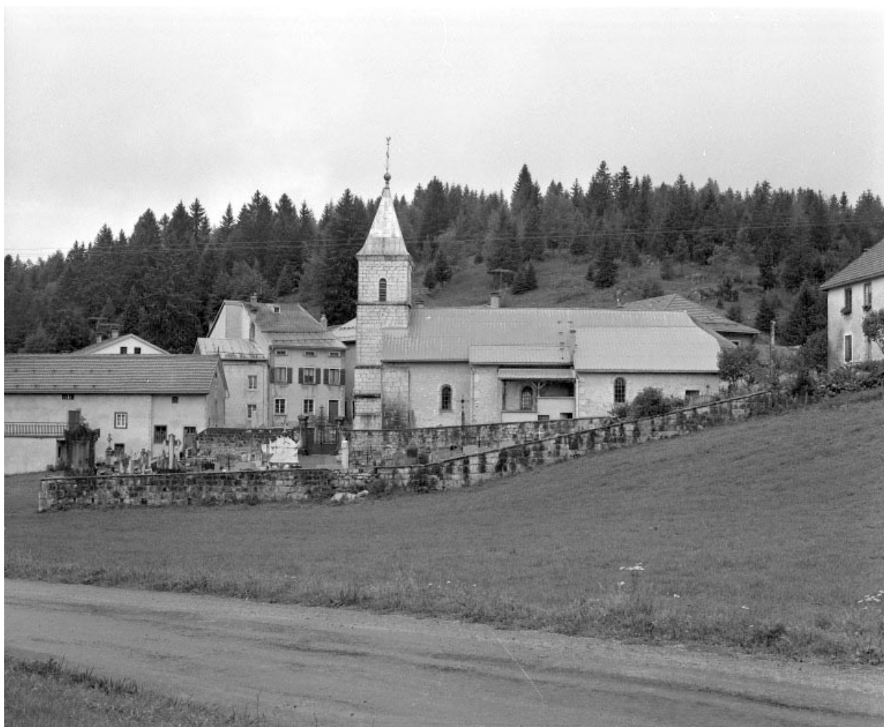
Extérieur : face sud.
