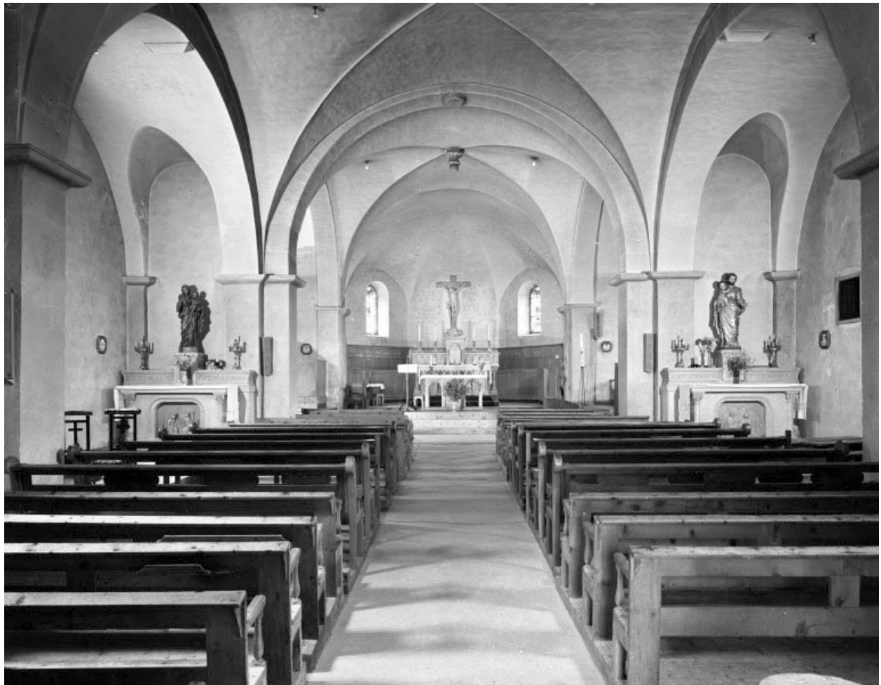
Le chœur vu depuis la nef.
