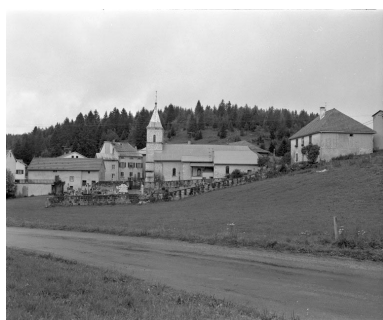
Vue de situation depuis le sud. Phot. Yves Sancey IVR43_19943901027X
