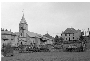
Extérieur : vue générale depuis le sud-ouest. Phot. Yves Sancey IVR43_19943901030X
