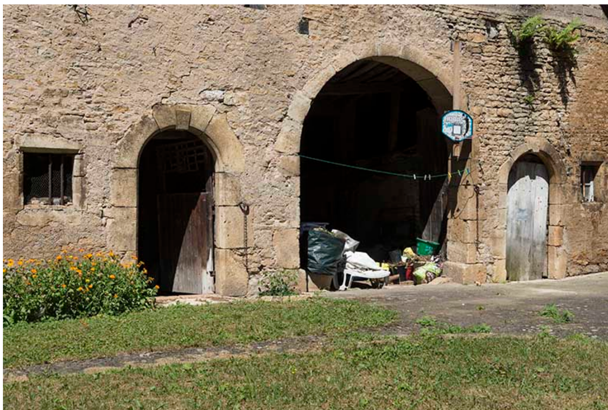
Portes de la remise.
